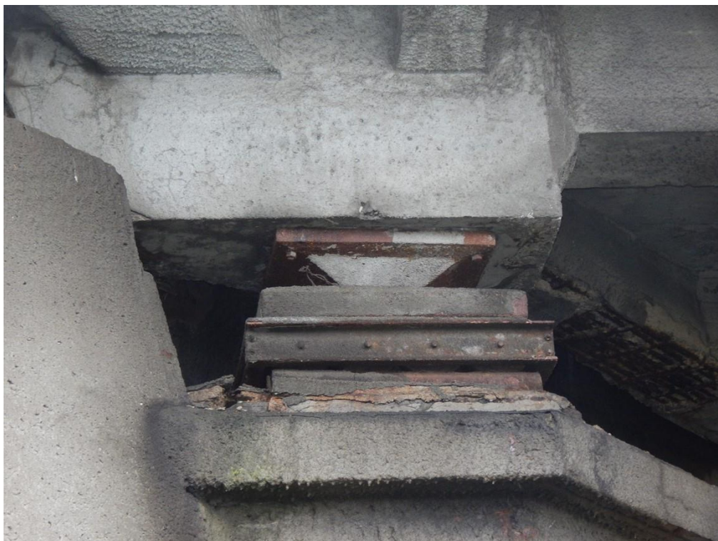
Fot. 23. Korozja elementów stalowych łożyska
