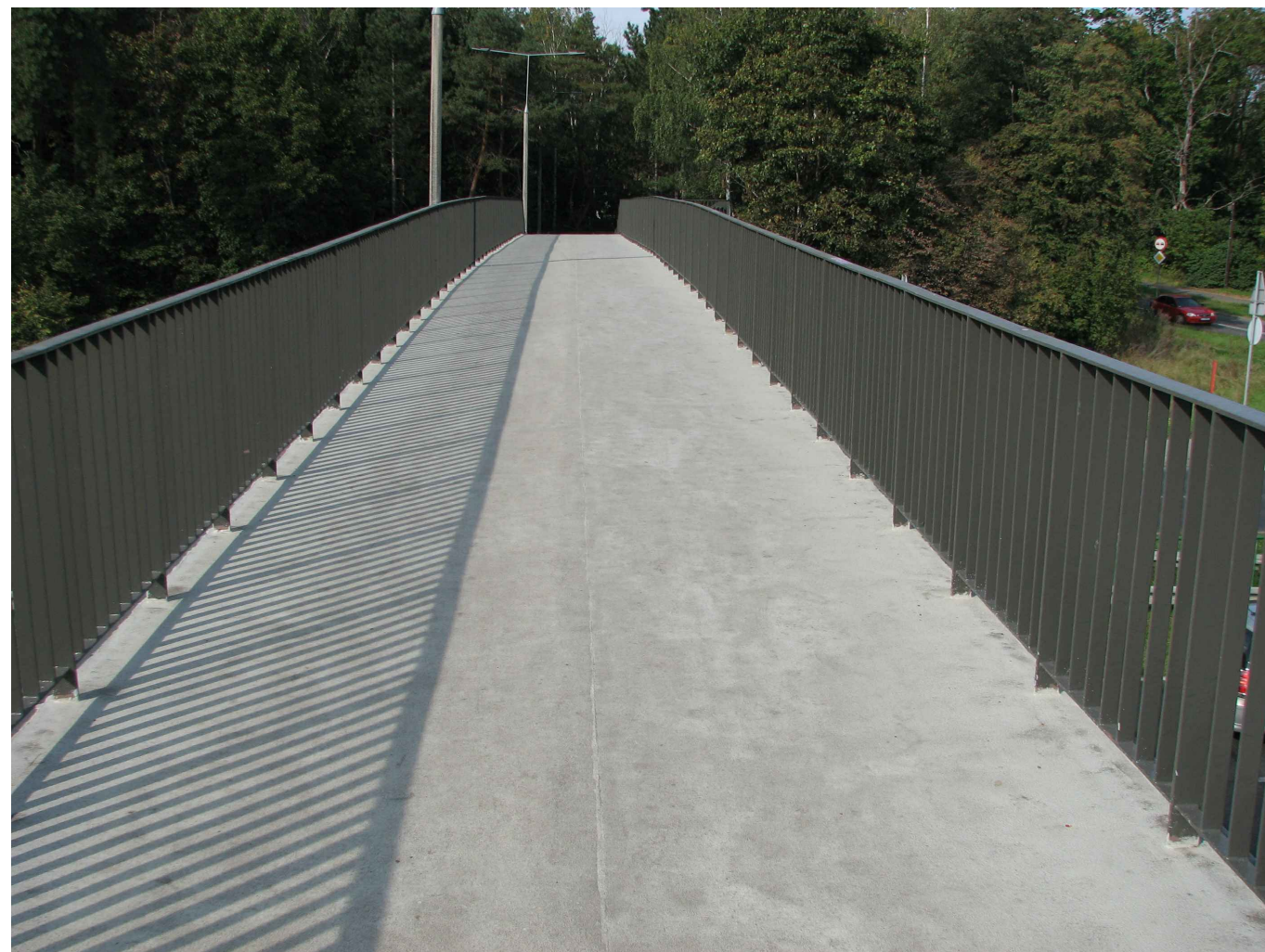
Fot. 3 . Widok nawierzchni na obiekcie
