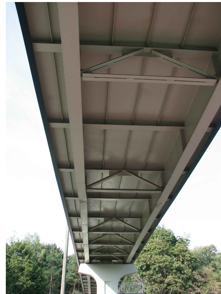
Fot. 2 . Widok konstrukcji od spodu
