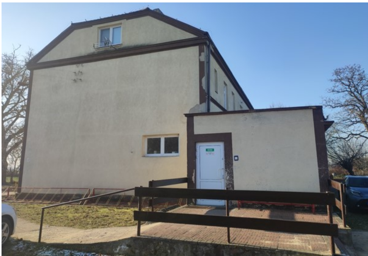
Fotografia 3 Wejście do budynku od strony wschodniej
