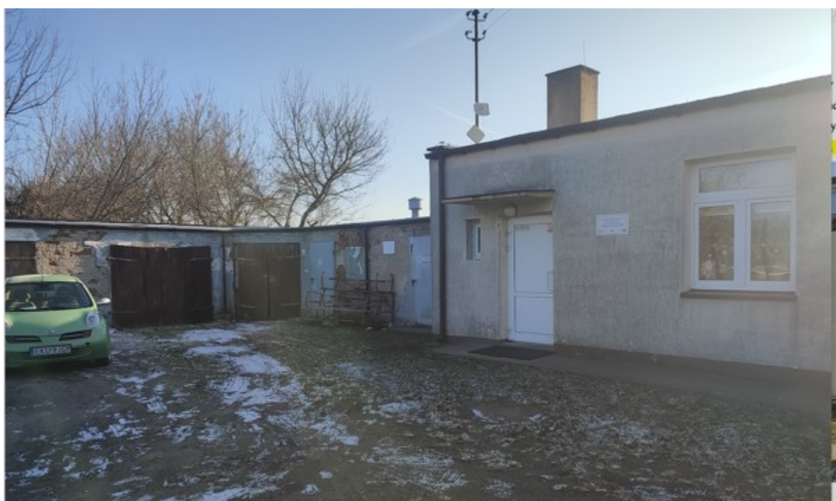
Fotografia 4 Przedszkole, kotłownia i budynki gospodarcze
