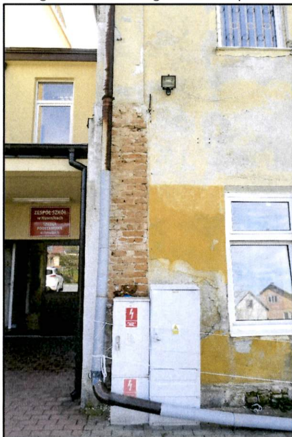
9., 10. Narożniki budynku: pn.-zach. i pd. zach., widoczny uskok lizeny na wysokości stropu nad parterem oraz ślady rowków boniowania. Fot. B. Potera, 2024 r.
