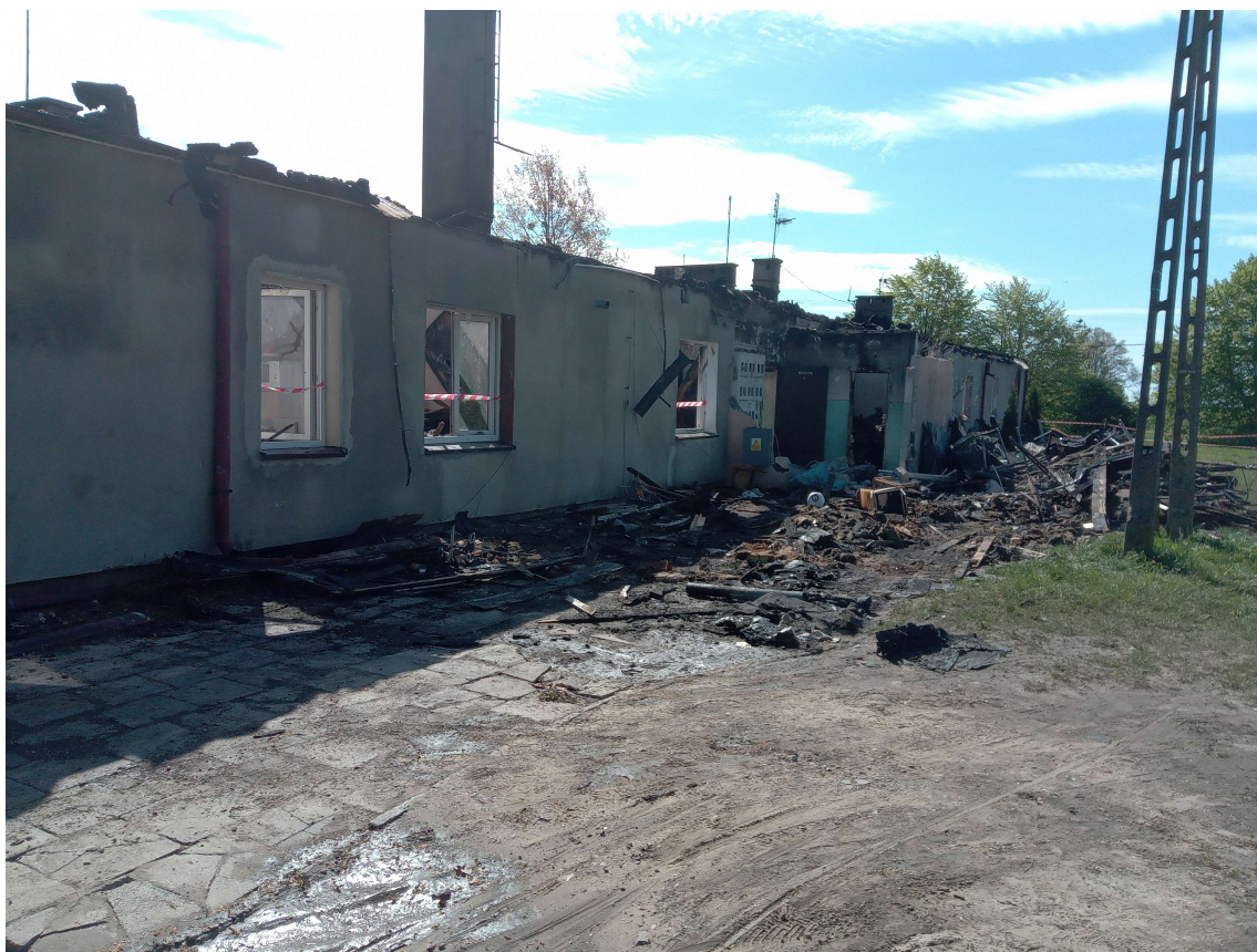
Fot.7. Widok elewacji zachodniej
