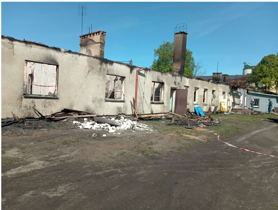
Fot.11. Widok elewacji wschodniej
