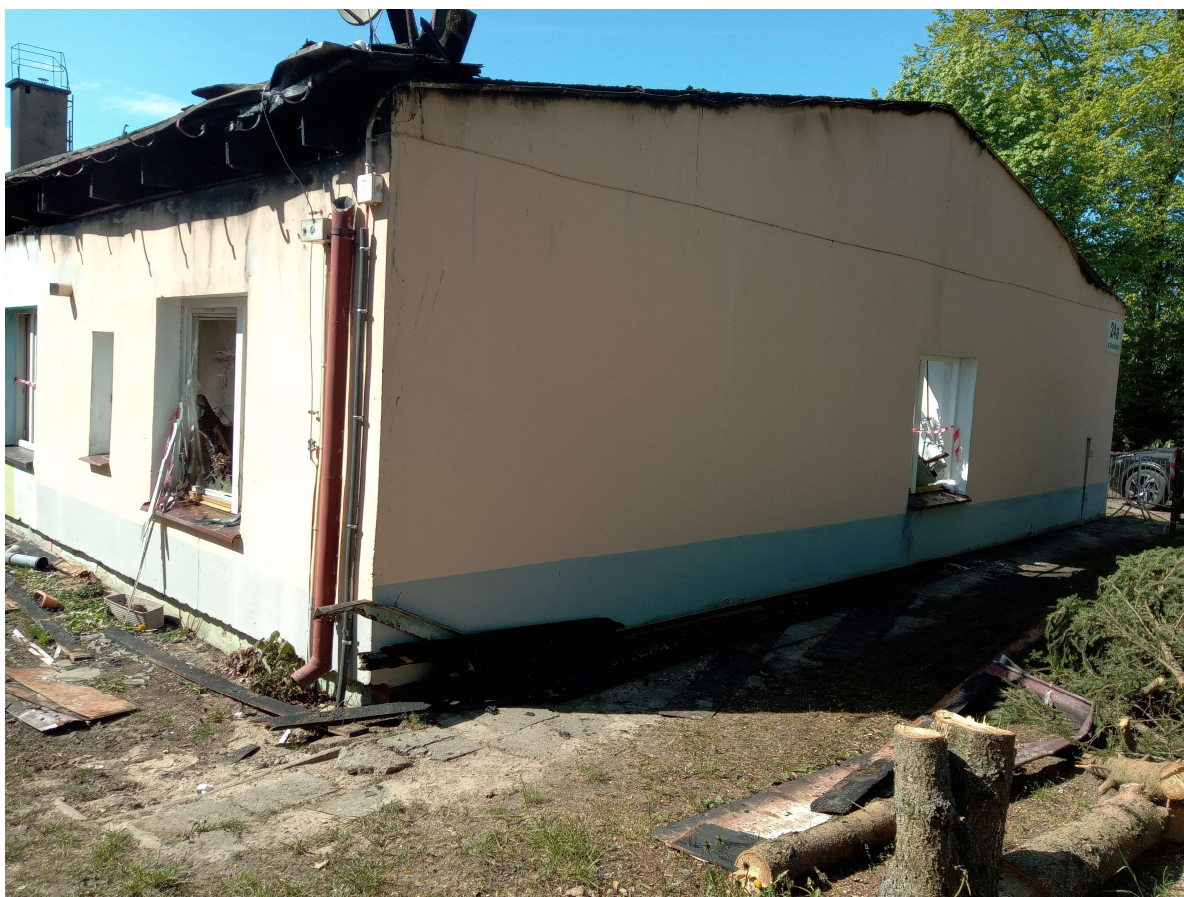
Fot.1. Widok elewacji północnej
