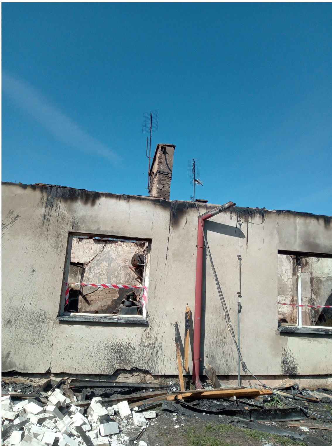
Fot.9 Widok elewacji wschodniej
