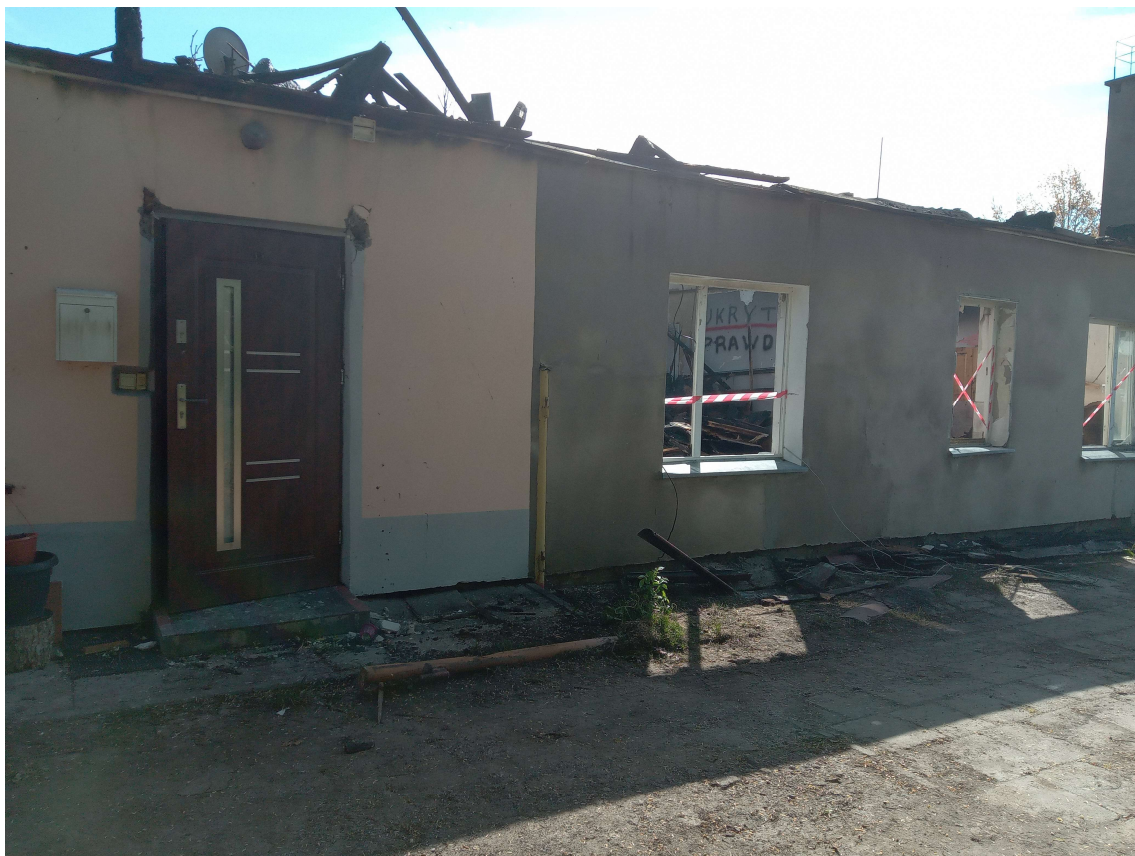
Fot.3. Widok elewacji zachodniej
