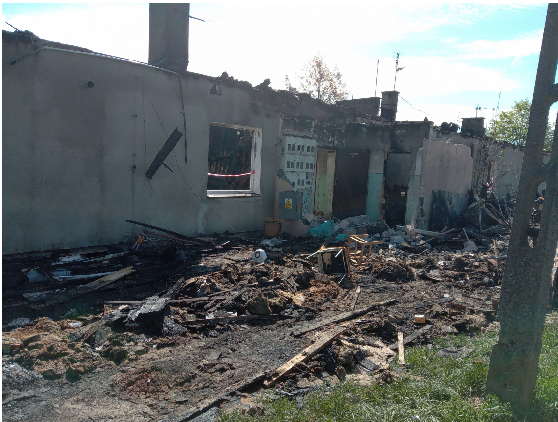
Fot.4. Widok elewacji zachodniej
