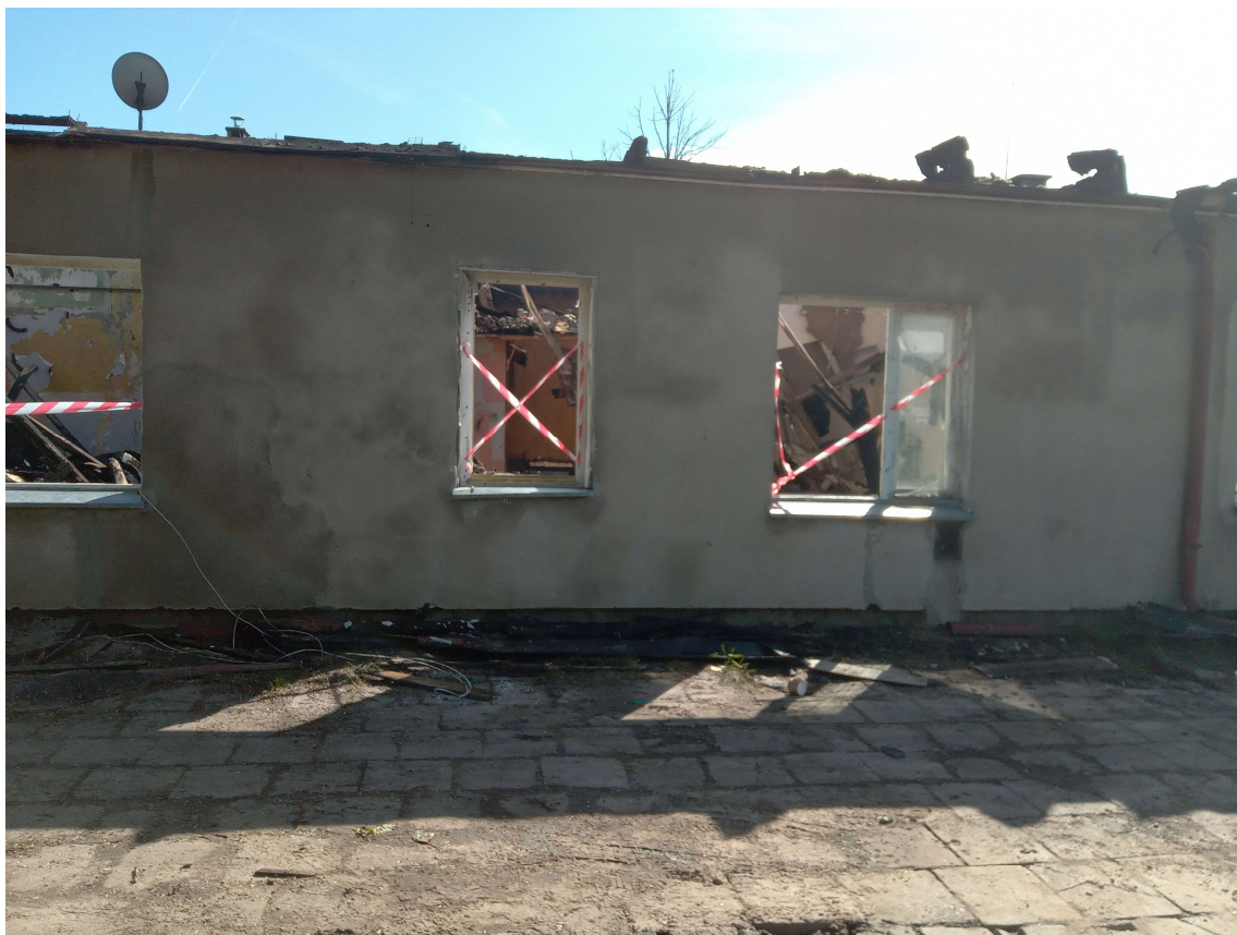
Fot.5. Widok elewacji zachodniej
