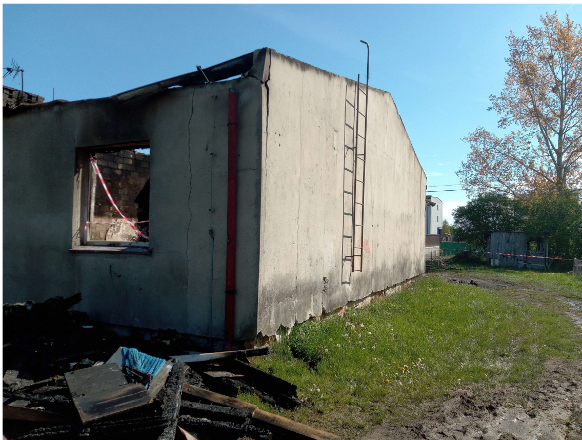
Fot.2. Widok elewacji południowej
