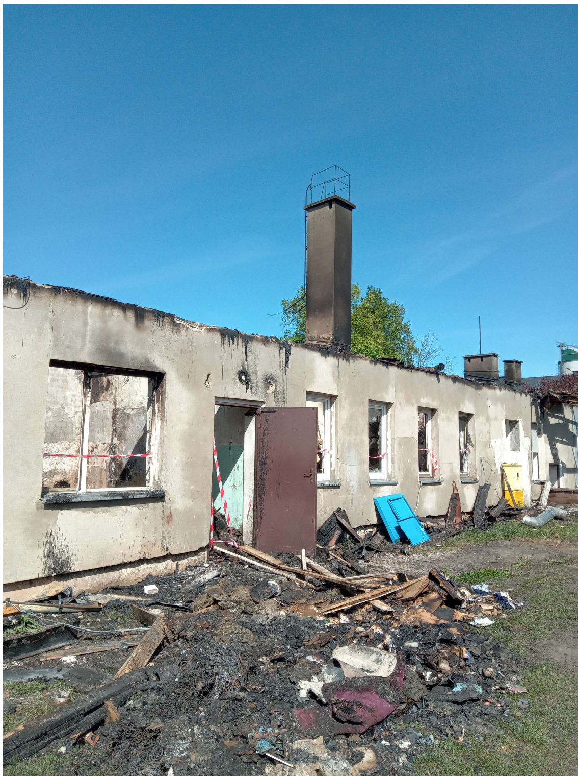
Fot.13. Widok elewacji wschodniej
