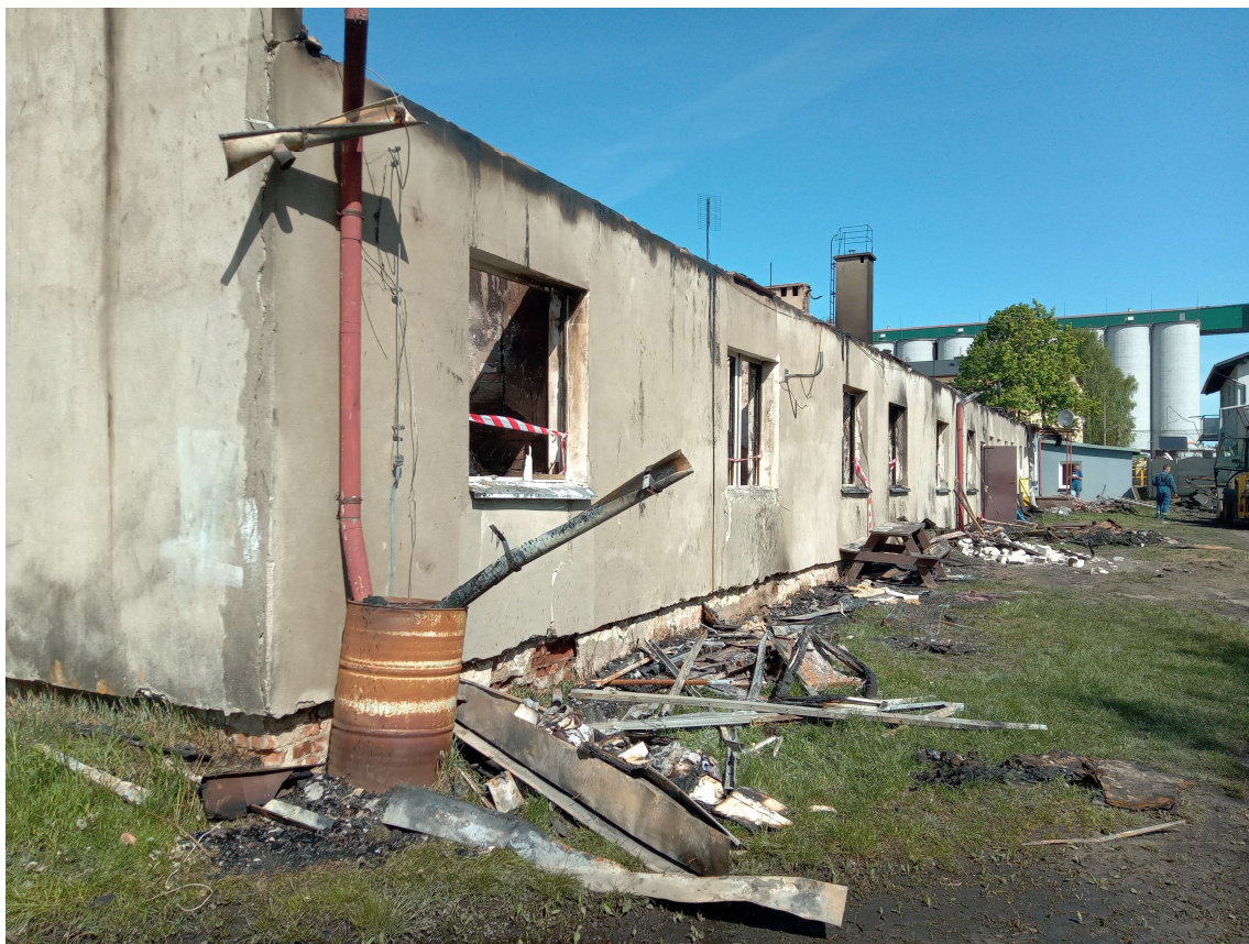
Fot.12. Widok elewacji wschodniej
