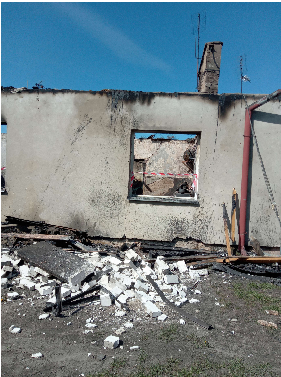
Fot.10. Widok elewacji wschodniej
