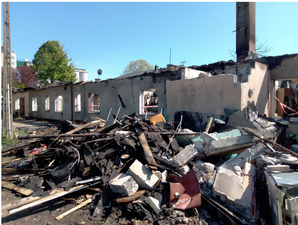
Fot.6. Widok elewacji zachodniej
