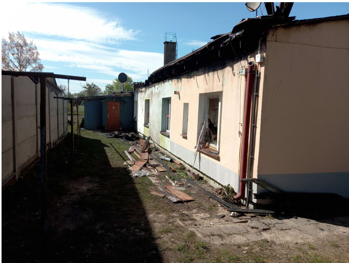
Fot.8 Widok elewacji wschodniej
