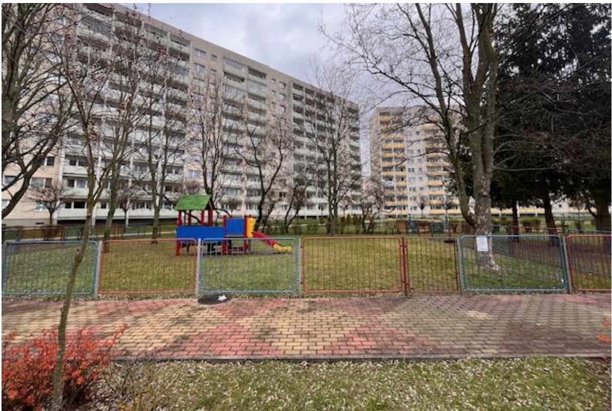
Fot. 4 – Część A - wydzielona dla grupy wiekowej 1-2 lata; widok od strony południowej
