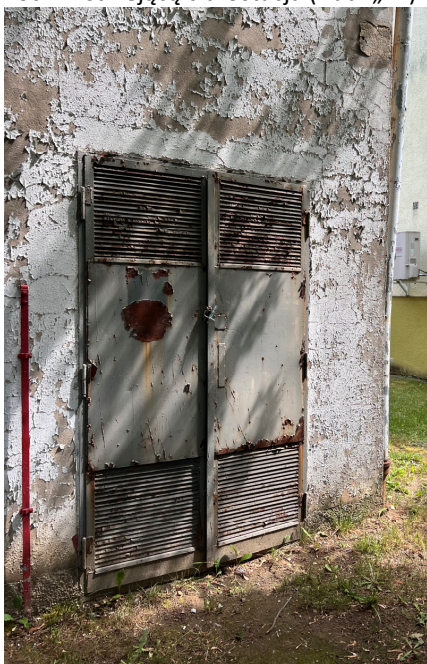
Fot. 3. Istniejącą miejsce dla falowników – fragment budynku do remontu (Bud. „G”)
