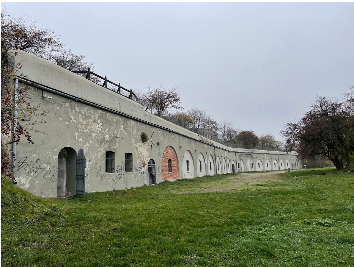
Fot. Fort XI "Duńkowiczki", elewacja frontowa, źródło: zbiory własne
