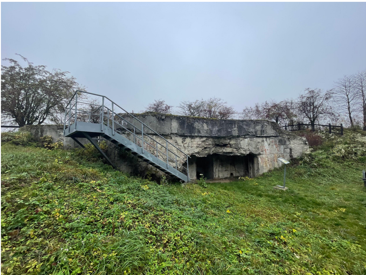
Fot. Fort XI "Duńkowiczki", stan istniejący, listopad 2022, źródło: zbiory własne
