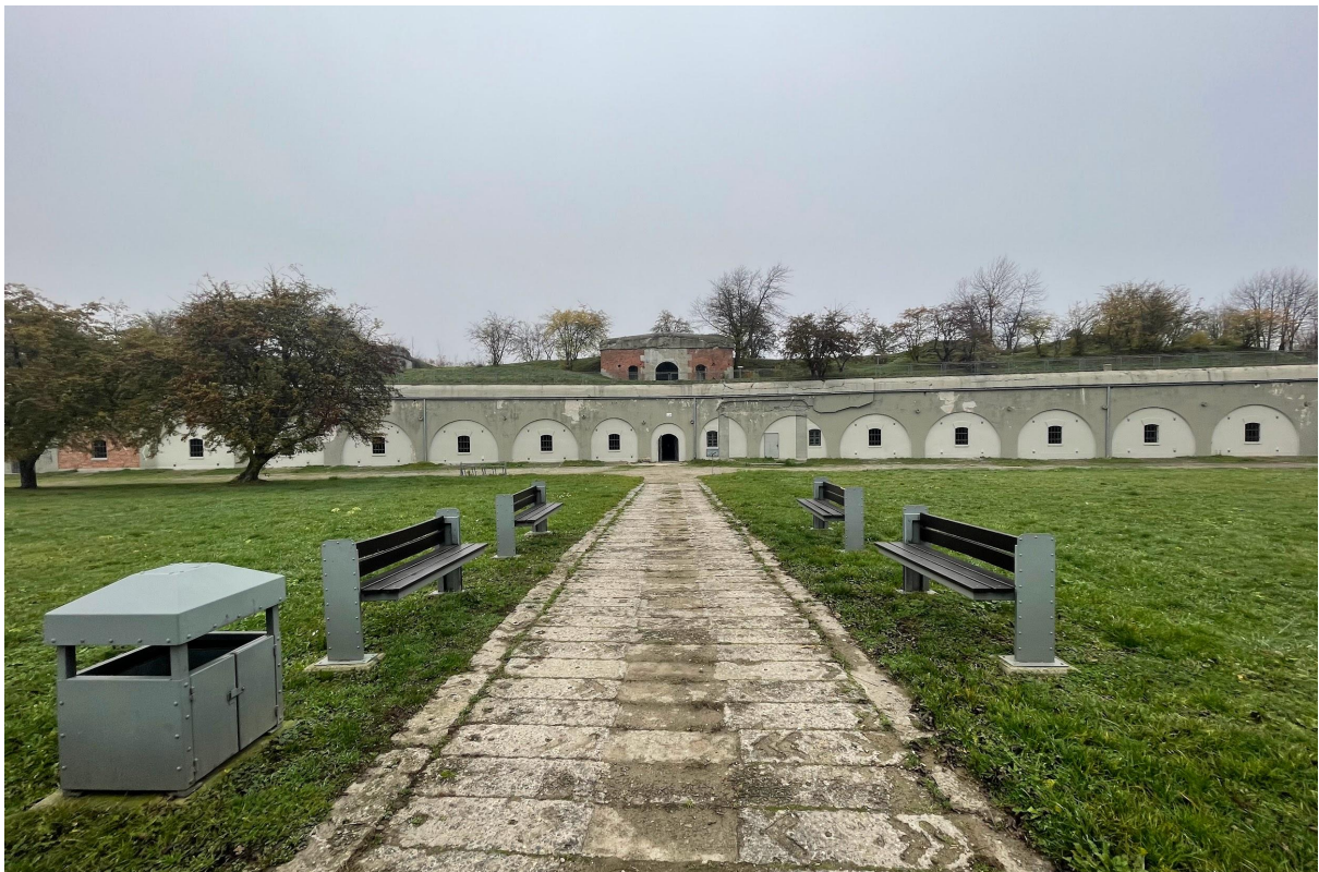
Fot. Wjazd na teren fortu XI "Duńkowiczki", źródło: zbiory własne
