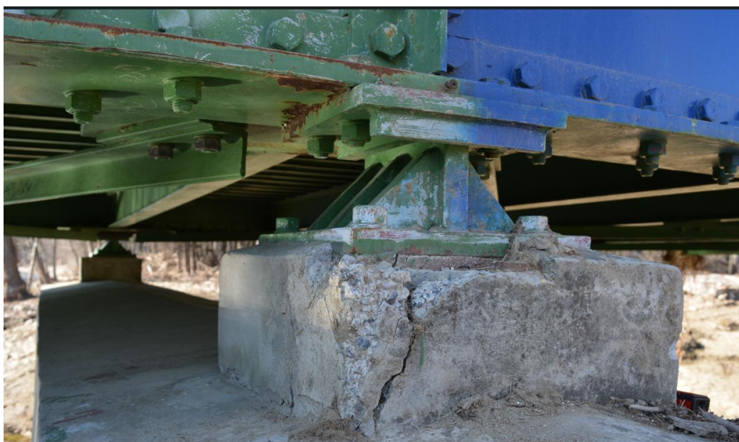
Rys.3.9. Oparcie dźwigara na łożysku (podpora pośrednia od strony wody górnej)
