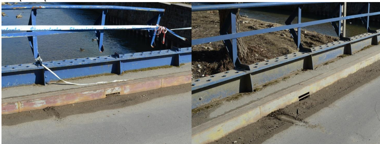
Rys.3.4. Wpusty krawężnikowe w ciągu obiektu
