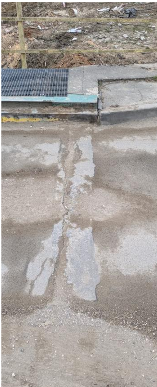
Rys.3.5. Dylatacja w ciągu obiektu mostowego od strony posesji Trzebieszowice 17
