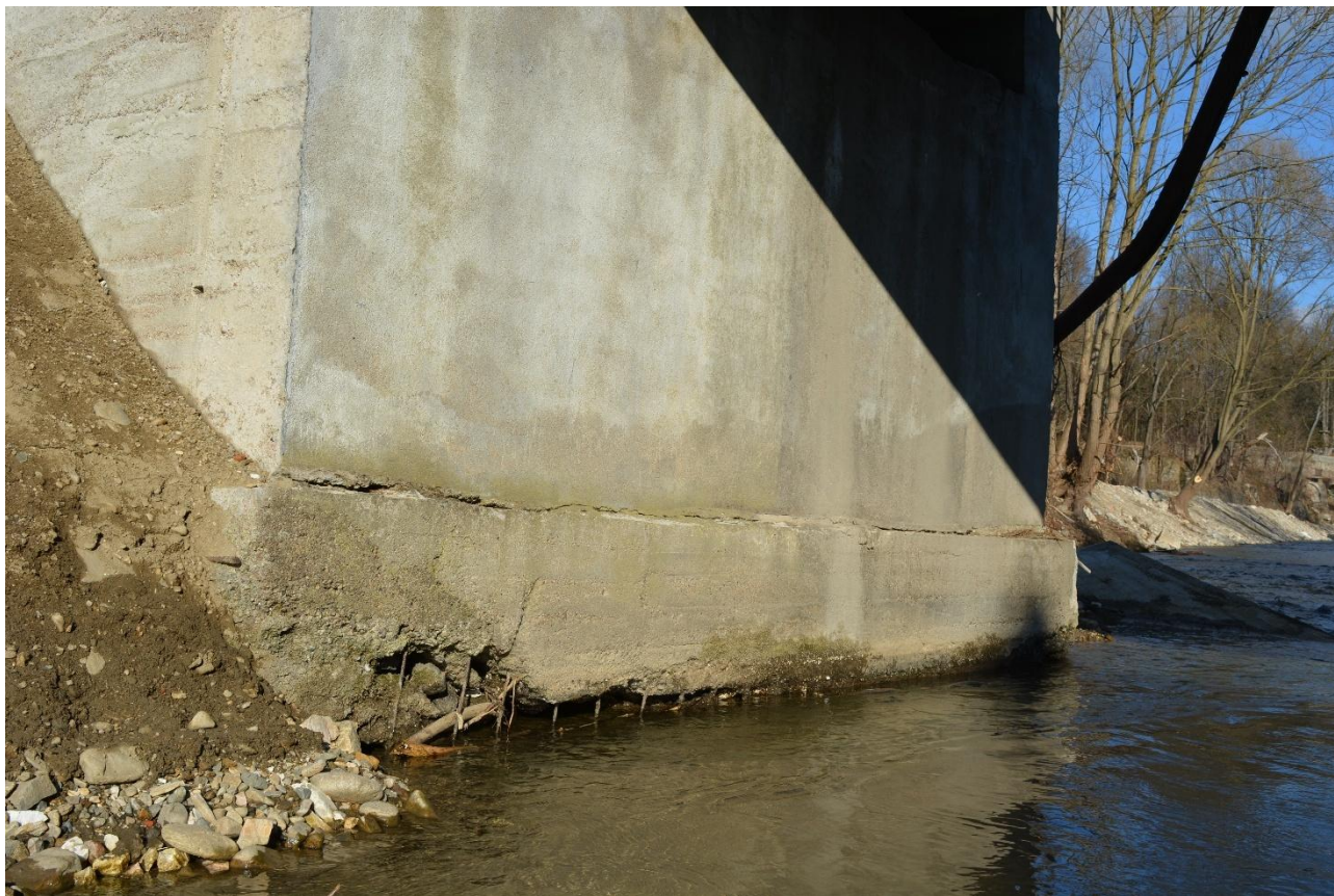
Rys.3.20. Fundament przyczółka mostu na prawym brzegu
