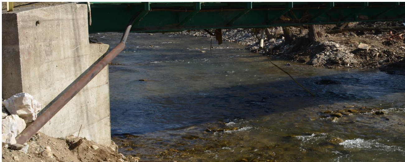
Rys.3.17. Fotografia przedstawiająca kabel teletechniczny przymocowany do obiektu
