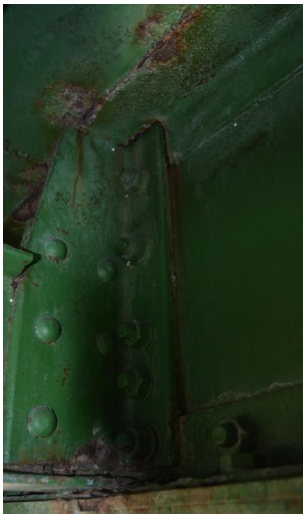
Rys.3.8. Widok spodu konstrukcji przęsła – połączenie poprzecznicy z dźwigarem głównym
