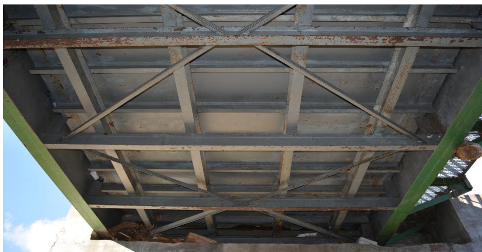
Rys.3.17. Oparcie ustroju nośnego na łożyskach od strony kościoła pw. św. Andrzeja Apostoła
