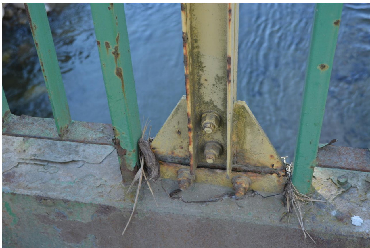
Rys.3.16. Połączenie blachownicy stalowej z wieszakiem za pomocą blachy węzłowej
