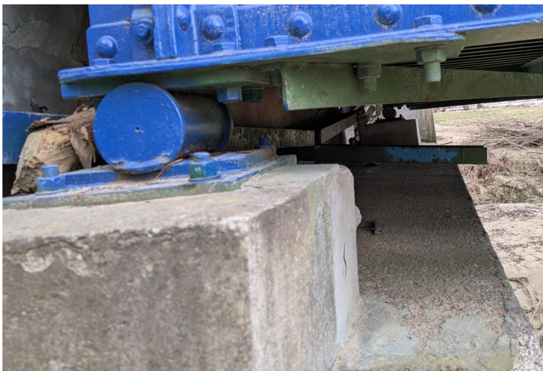
Rys.3.11. Oparcie dźwigara blachownicowego na przyczółku od dojazdu z parku zamkowego Zanieczyszczenie powierzchni betonowych. Widoczne lokalne ogniska korozji w obrębie łożysk oraz odspojenia powłoki malarskiej.
