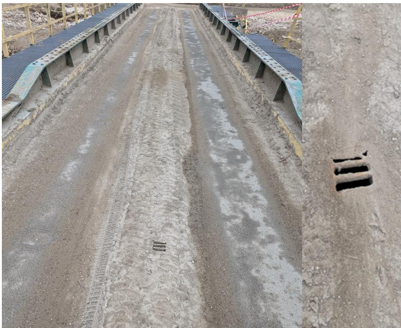
Rys.3.4. Wpusty w ciągu obiektu
