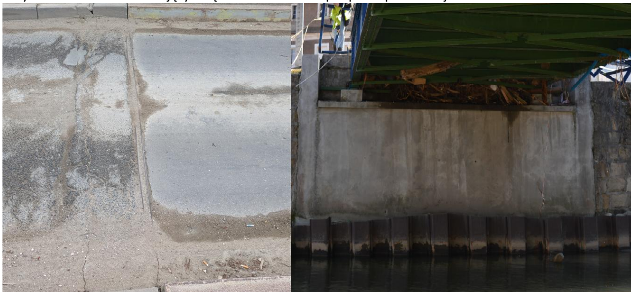
Rys.3.5. Dylatacja w ciągu obiektu mostowego/widok przyczółka od strony drogi wojewódzkiej
