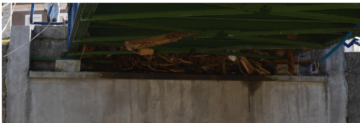
Rys.3.12. Oparcie dźwigara blachownicowego (przyczółek od strony dojazdu DW nr 392) Zanieczyszczenie powierzchni betonowych. Zanieczyszczenia strefy pomiędzy ścianką żwirową, a łożyskami spowodowane naniesionymi elementami podczas powodzi.
