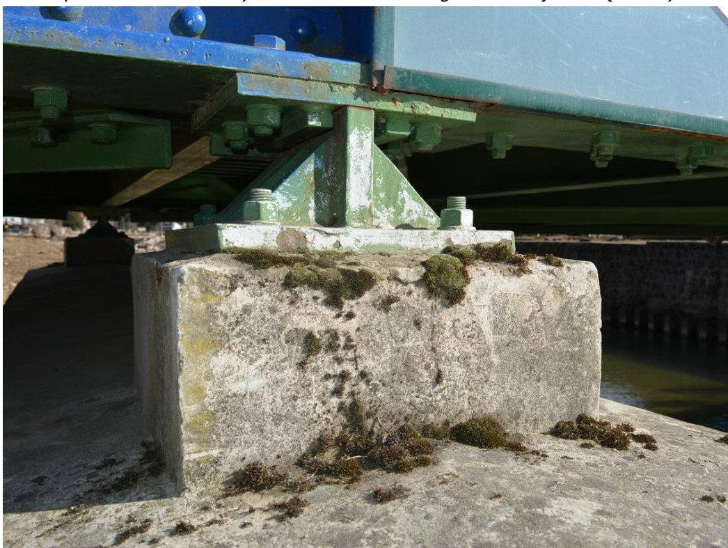
Rys.3.10. Oparcie dźwigara na łożysku (podpora pośrednia od strony wody dolnej)
