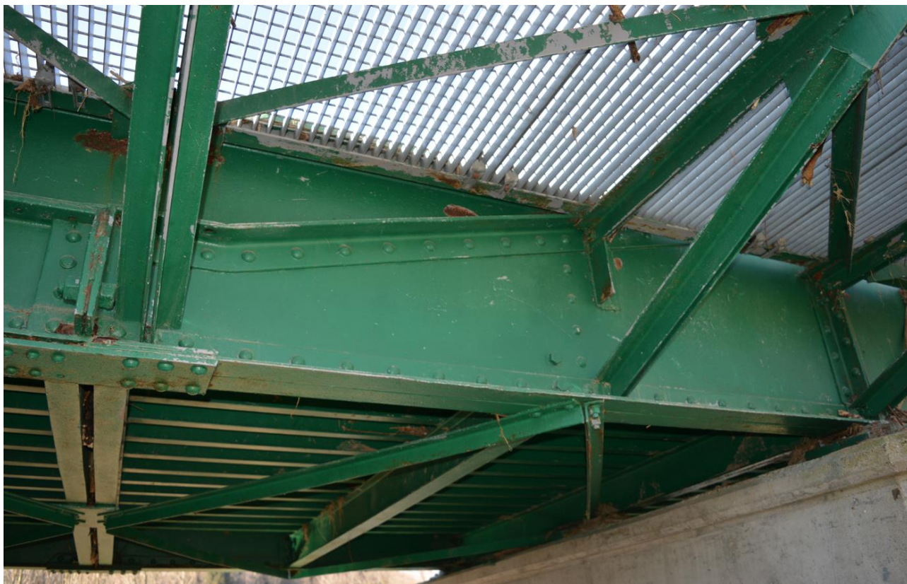
Rys.3.7. Widok spodu konstrukcji przęsła. Fotografia ustroju nośnego wraz z konstrukcją wsporników – ukazane przejście dźwigarów głównych z walcowanych na blachownicowe
