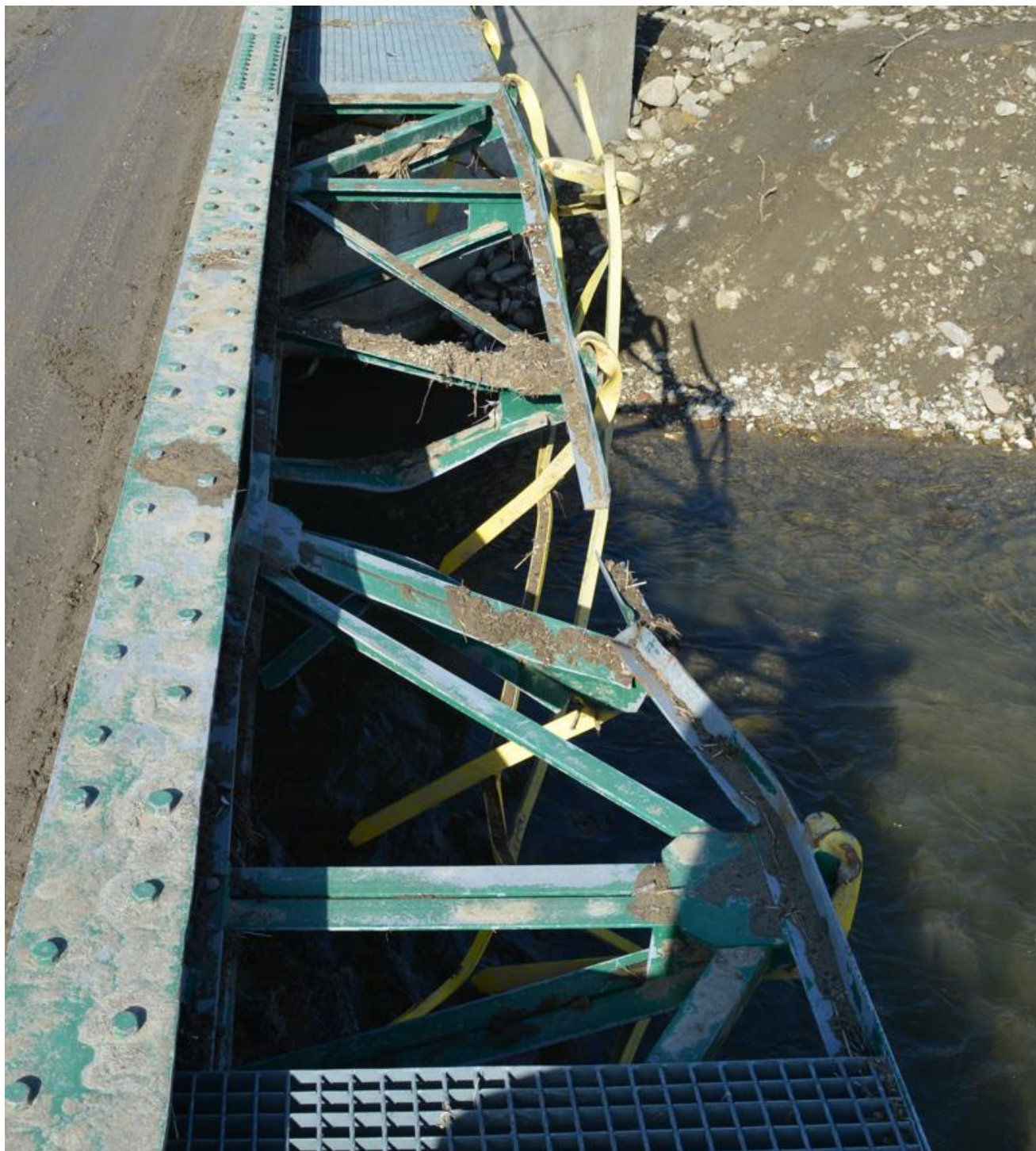
Rys.3.16. Widok uszkodzonego wspornika od strony wody górnej
