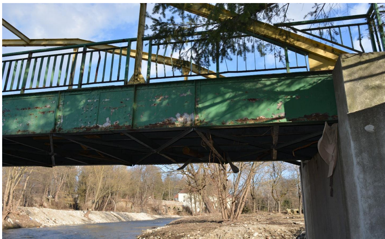
Rys.3.5. Balustrady od strony wody dolnej
