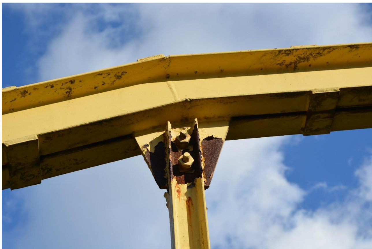
Rys.3.2 Połączenie stalowego łuku z wieszakiem za pomocą blachy węzłowej
