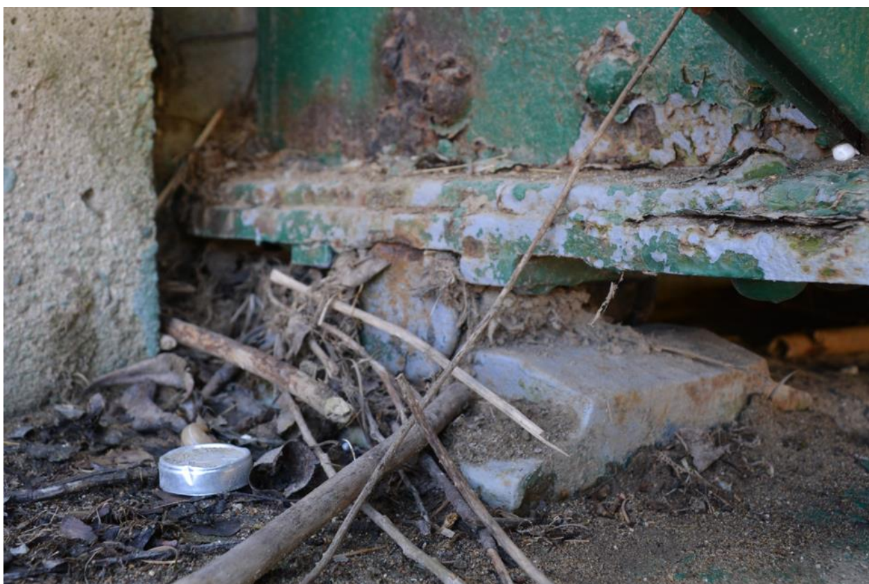
Rys.3.9. Fotografia przedstawiająca łożysko na przyczółku od strony posesji Trzebieszowice 179
