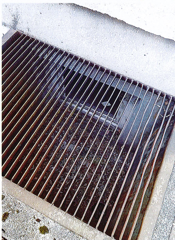
Fotografia nr 8: Tynki w doświetlaczach piwnicznych są uszkodzone, należy zwrócić uwagę również na zatkane odpływy wody.
