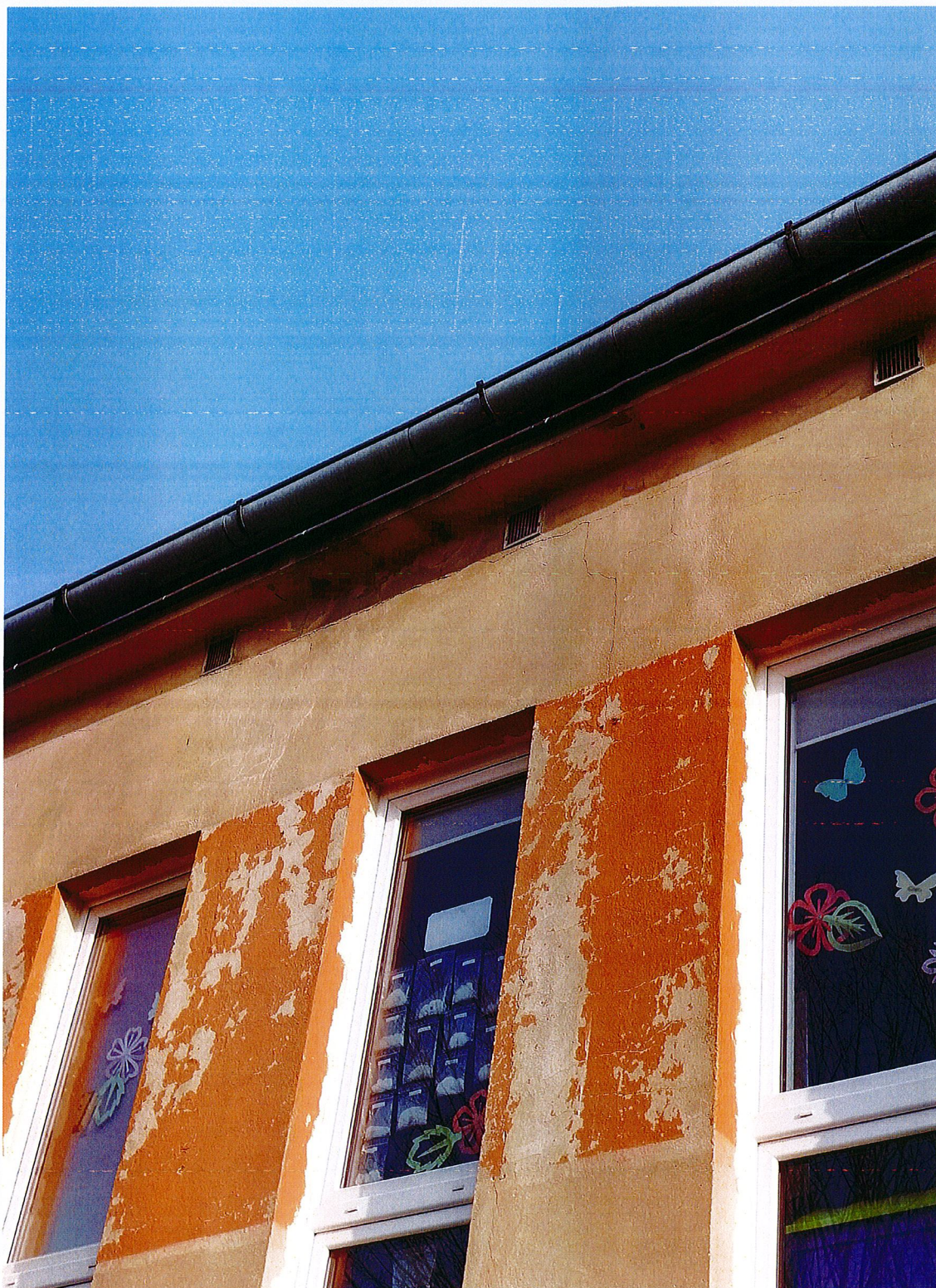
Fotografia nr 9: Na elewacji budynku widoczne są złuszczenia wyprawy malarskiej oraz zacieki spowodowane uszkodzeniem lub niewłaściwym wykonaniem opierzenia.
