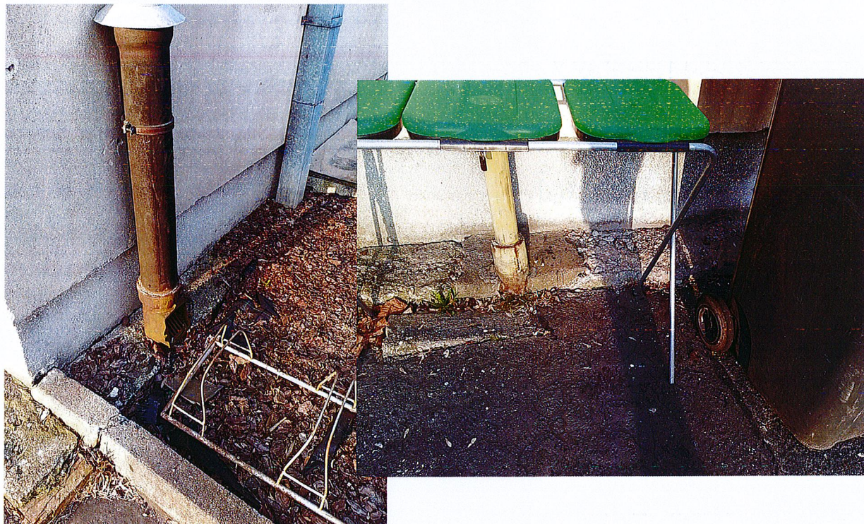
Fotografia nr 6 i 7: Uszkodzenie strefy cokołowej i niewłaściwy sposób odprowadzenia wód opadowych może powodować uszkodzenie i zawilgocenie przegród budowlanych.
