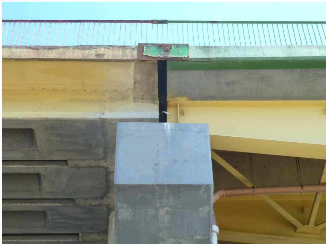
Fot. 3. Zacieki i zanieczyszczenia betonu belek oczepowych i filarów w obrębie dylatacji.
