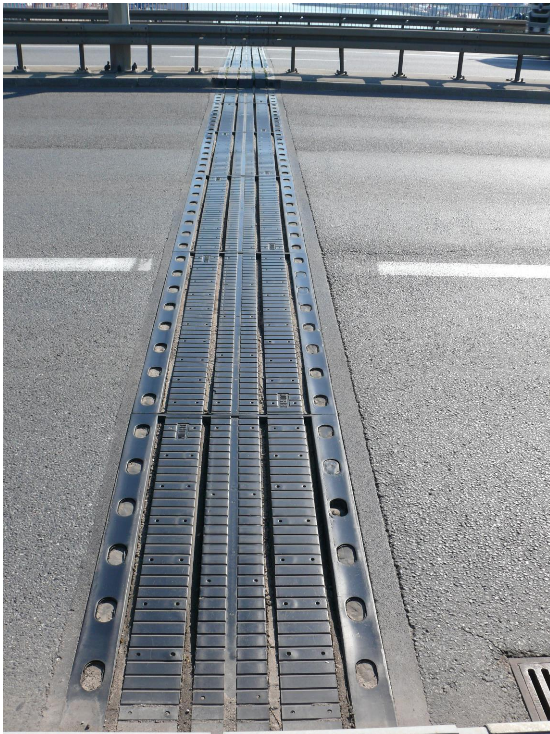
Fot. 2. Widok dylatacji nad filarem 74a.
