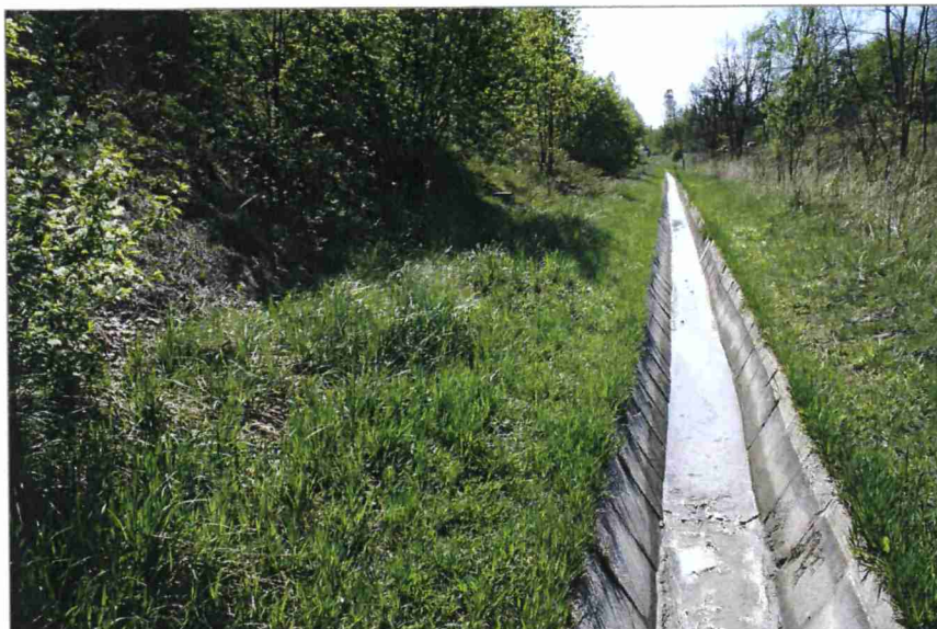
Fot. 4. Rów opaskowy z zasolonymi wodami u podnóża osadnika II, po stronie południowej (maj 2007 r., widok w kierunku wschodnim wzdłuż ul. Podmokłej).
