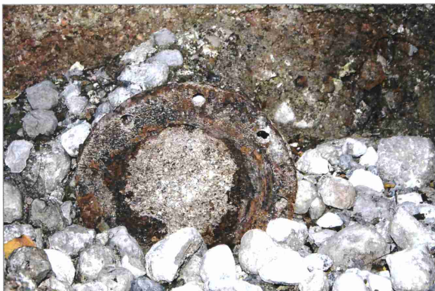
Fot. 8. Wykop j.w. – dawna rura drenażowa, całkowicie "zaślepiąca" osadami (czerwiec 2007 r.)
