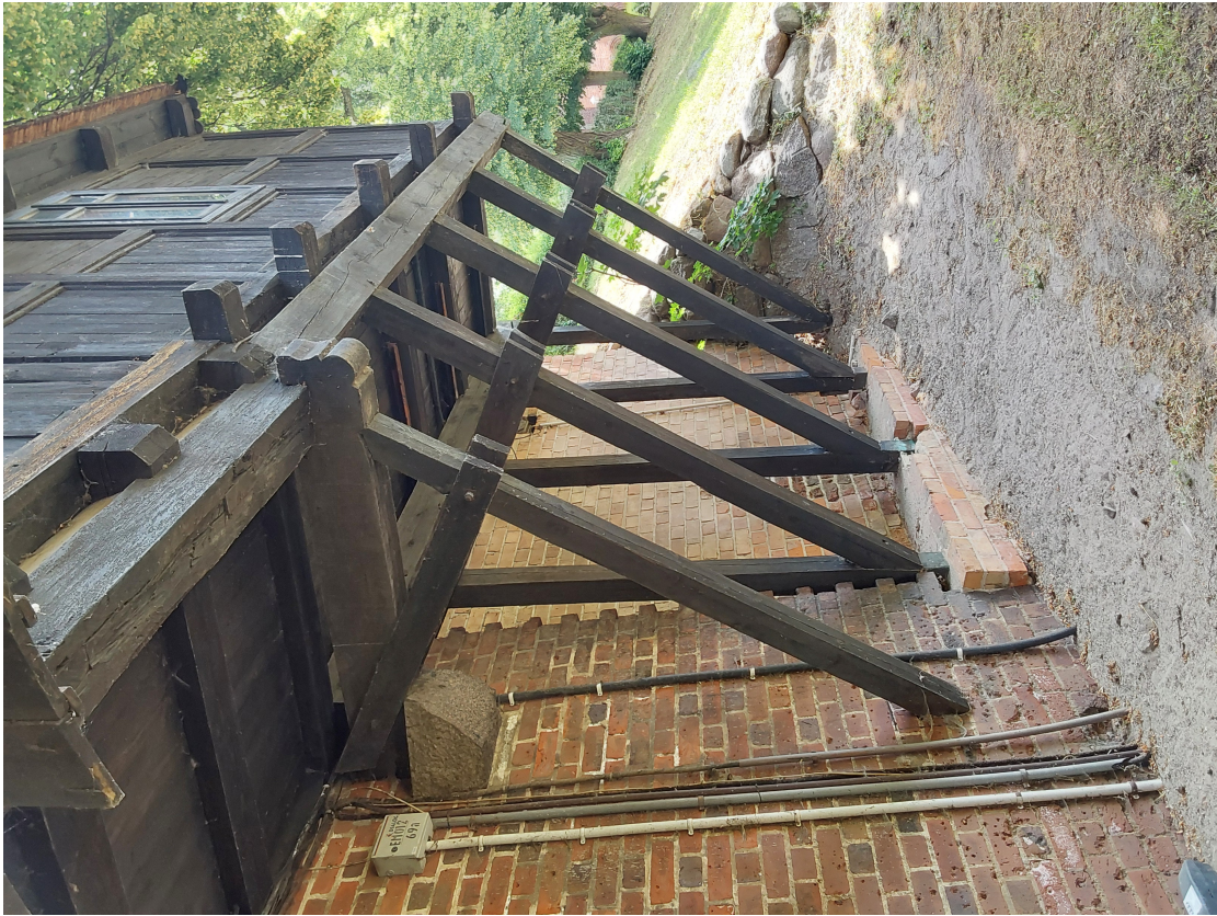
Fot. 4 Podparcie konstrukcji budynku, widok wszystkich podpór od 1 do 5
