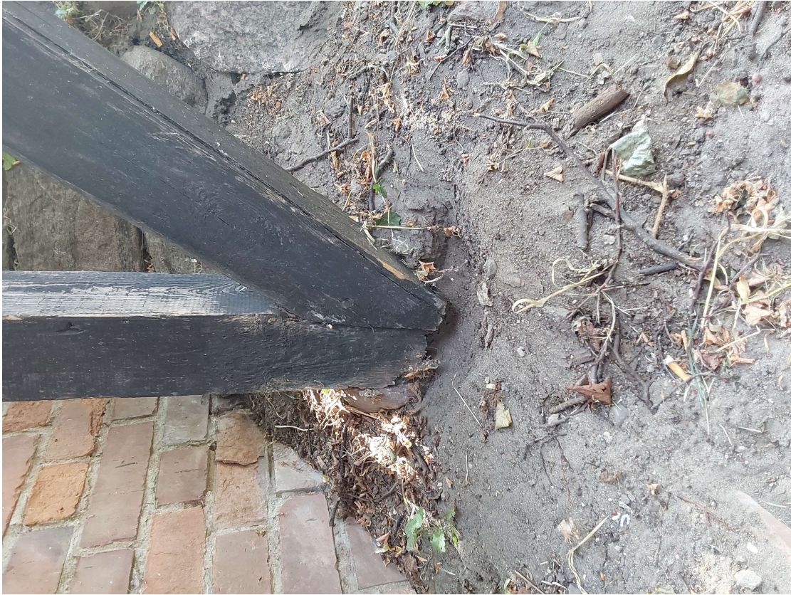
Fot. 5 Podparcie słupa nr 5, widoczna skorodowana podstawa słupa (słup wisi w powietrzu)
