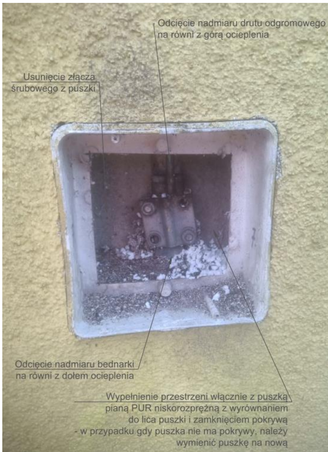
Rysunek 6 - przykładowe zabezpieczenie istniejącej puszkii z demontażem złącza probierczego
