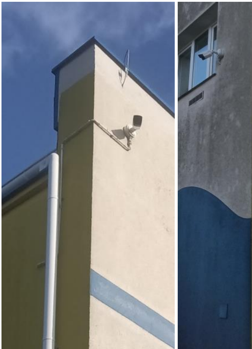
Rysunek 4 - zainstalowane urządzenia bez zachowania przerwy izolacyjnej od zwodów pionowych
