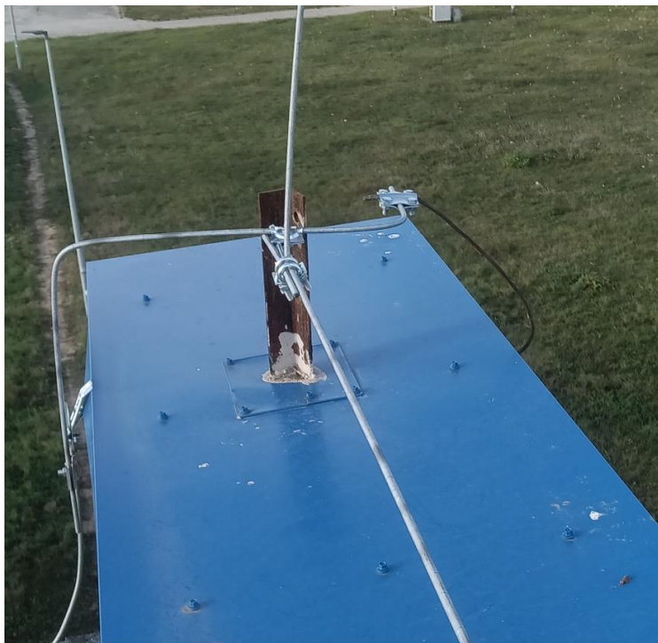
Rysunek 2 - za duże uchwyty naprężne wyposażone w dodatkowy drut w celu zablokowania drutu odgromowego
