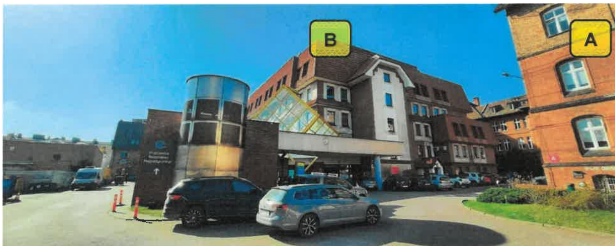
Fot. 2. Budynek „B”. Widok od strony północnej – bramy wjazdowej od ul. Jackowskiego. Źródło własne.
