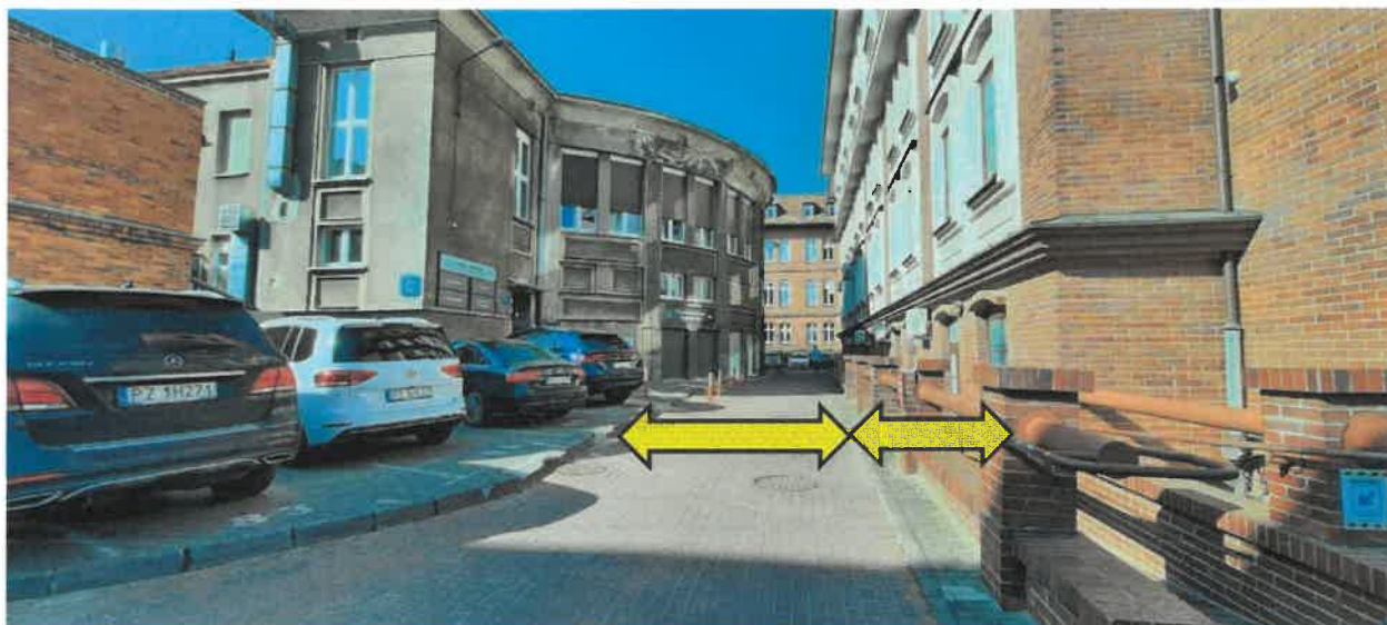
Fot. 39. Widok południowej części budynku „B” oraz budynku „C”. Droga pożarowa pomiędzy budynkami o szerokości 3,5 m, oddalona od budynku „B” o 1,9 m. Źródło własne.
