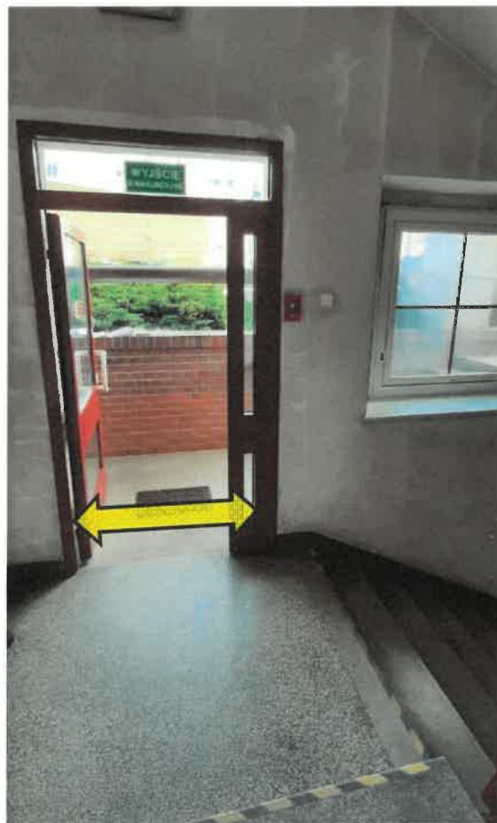
Fot. 28, 29. Klatka 1. Biegi żelbetowe z noskami. Wyjście z klatki na zewnątrz budynku (1,02 m). Źródło własne.
