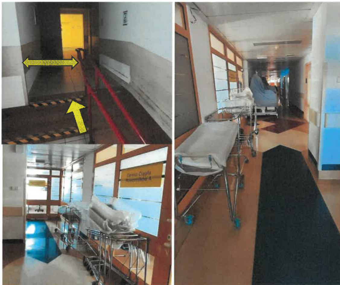
Fot. 10,11,12. Piętro 4. Na zdjęciach przedstawiono połączenie z budynkiem „A” – schody/pochylnia, oraz komunikację w obrębie oddziału neonatologii. Źródło własne.
