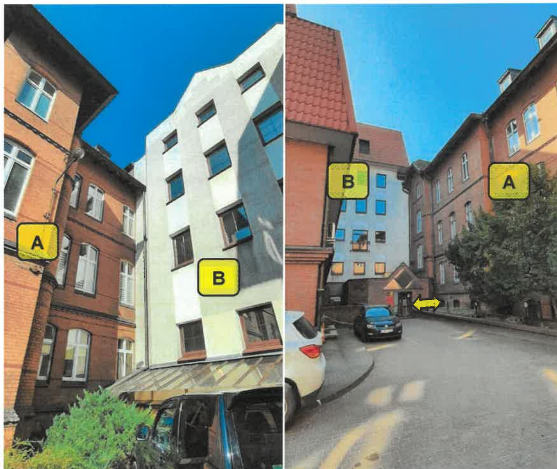
Fot. 5 i 6. Odległość pomiędzy budynkiem „A” i „B”. Źródło własne.
