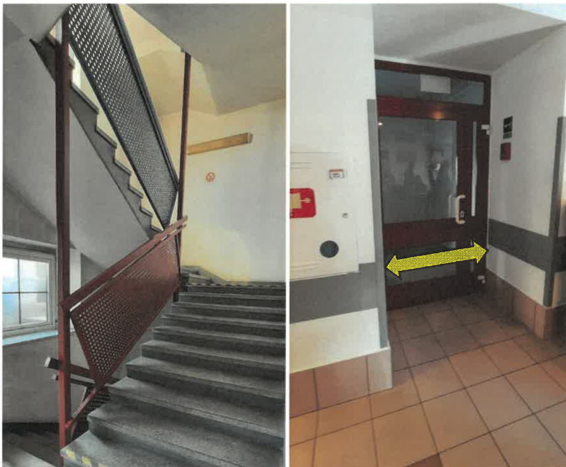
Fot. 30, 31. Klatka 2. Biegi żelbetowe z noskami. Wyjście z klatki do holu (1,07 m). Źródło własne.
