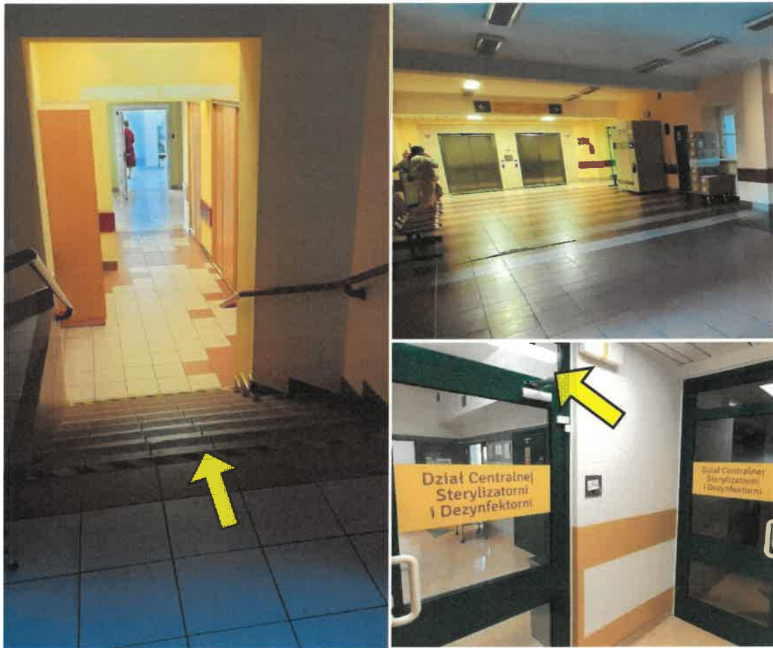
Fot. 15,16,17. Piętro 2. Na zdjęciach przedstawiono połączenie z budynkiem „A” –schody wewnętrzne, oraz hol windowy, oraz szklenia/naświetla stałe w obudowie drogi ewakuacyjnej. Źródło własne.
