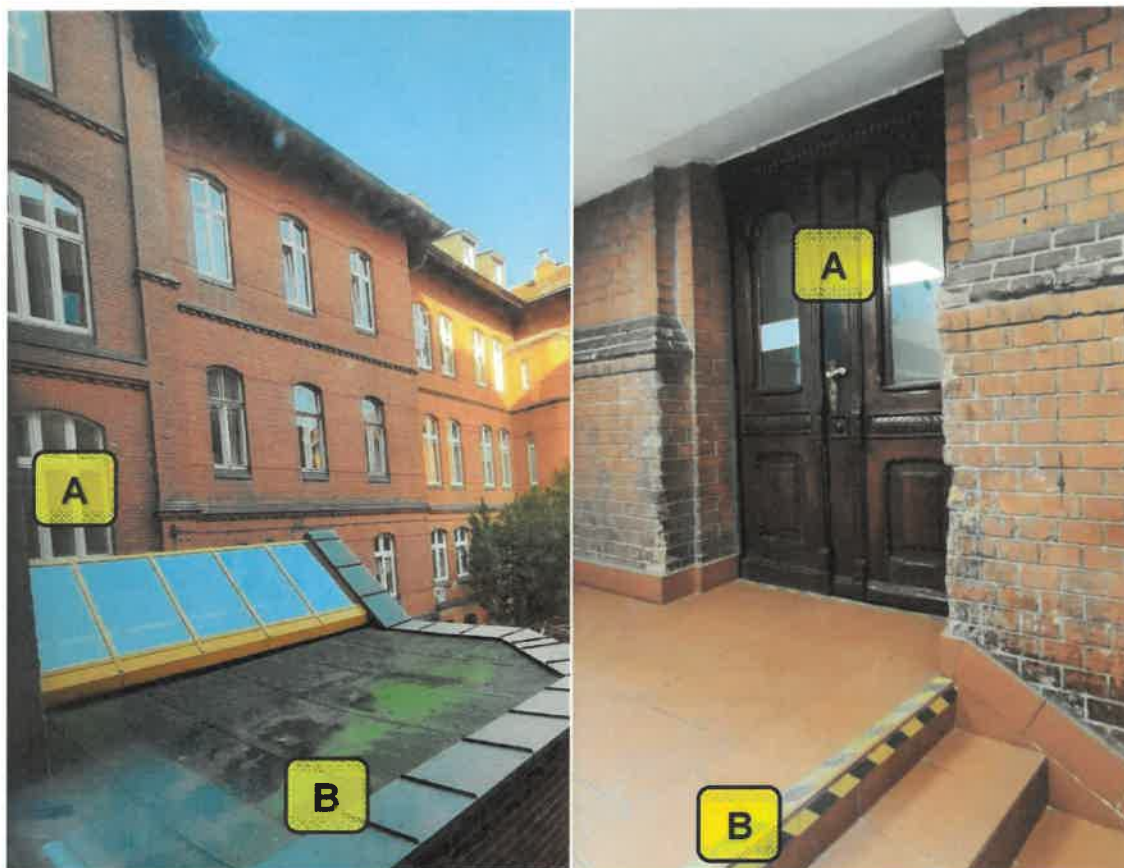
Fot. 7 i 8. Odległość pomiędzy budynkiem „A” i „B”. Po lewej zdjęcie przekrycia dachu nad wejściem B3 do budynku B. Po prawej zdjęcie drzwi pomiędzy budynkami A i B na parterze – drzwi istniejące do zachowania o charakterze zabytkowym. Źródło własne.
