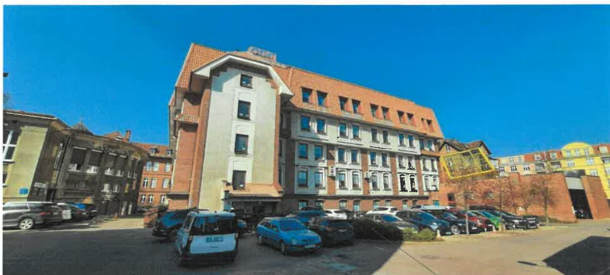
Fot. 38. Widok wschodniej części budynku. Źródło własne.
