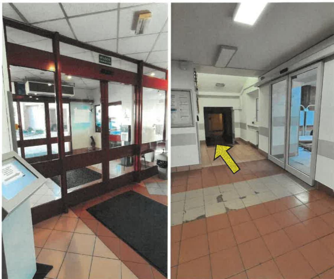
Fot. 23,24. Parter. Na zdjęciach przedstawiono połączenie z budynkiem „A”, schody wewnętrzne, oraz drzwi przesuwne wyjście B1 i B3 przy budynku A. Źródło własne.
