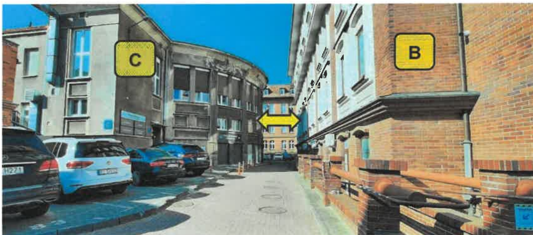
Fot. 4. Odległość pomiędzy budynkiem „B” i „C” – nieprawidłowość. Źródło własne.
