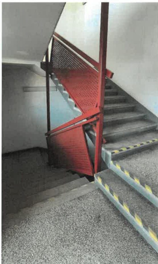
Fot. 28, 29. Klatka 1. Biegi żelbetowe z noskami. Wyjście z klatki na zewnątrz budynku (1,02 m). Źródło własne.
