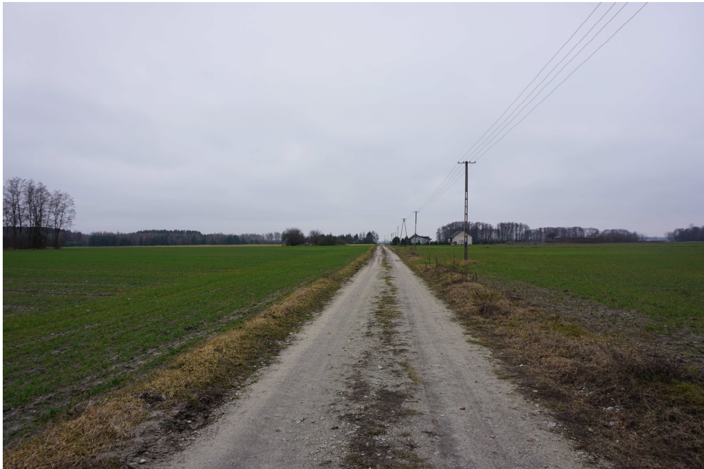
Zdjęcie nr 3. Widok przedstawia istniejący stan nawierzchni drogi o nawierzchni gruntowej z kruszywem łamanym.
