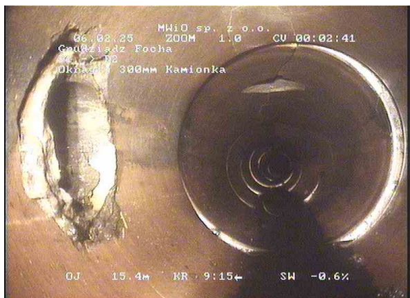
fde9dcf6-67df-48e1-b123-ec72700b95c3_20250206_123916_164.jpg, 00:02:31, 15.97 Połączenie, proste połączenie - wywiercone, otwarte, 150mm
