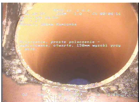
6e3bfe73-f7f3-4913-aab0-0a30a95d1599_20250206_124144_575.jpg, 00:04:13, 24.12 Połączenie, proste połączenie - wydłutowane, otwarte,
