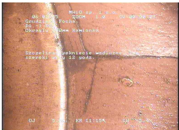
829cb6b8-f486-4bba-8221-e17543c4667d_20250206_123636_984.jpg, 00:00:36, 5.21 Szczelina, pęknięcie wzdłużne, 1mm szeroki przy 12 godz.
