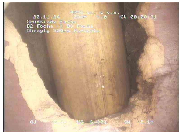
f21faa95-455a-4a00-8070-5b49bab74a5e_20241122_004003_717.jpg, 00:00:26, 0.44 Inne przeszkody, zewnętrzne przewody lub kable
