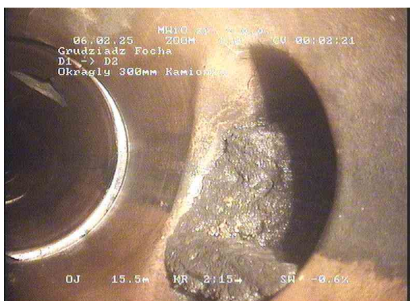
1f9330c4-b2fd-4b97-9819-d6dd77c59628_20250206_123845_831.jpg, 00:02:12, 15.80 Połączenie, łącznik, przyłącze zamknięte, 150mm wysoki przy
