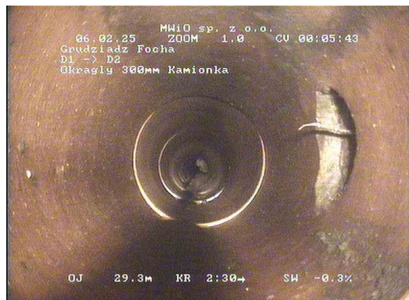
050043ac-5835-49d5-8799-ca050aca7521_20250206_124325_212.jpg, 00:05:30, 30.06 Połączenie, proste połączenie - wywiercone, otwarte, 150mm
