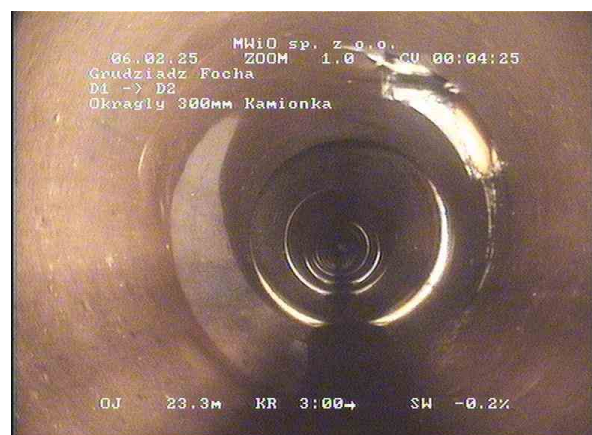
7512f299-c01f-4444-a523-b0644ee04b4d_20250206_124154_115.jpg, 00:04:13, 24.12 Połączenie, proste połączenie - wydłutowane, otwarte,
