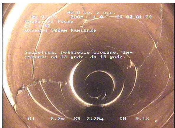
004e88d7-2891-4af5-84aa-92d90472f620_20250206_123753_572.jpg, 00:01:37, 8.05 Szczelina, pęknięcie złożone, 1mm szeroki od 12 godz. do 12
