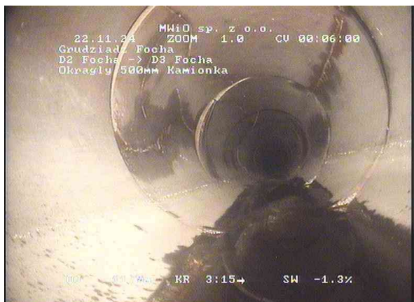
4cdfb1c4-2529-45b9-9bed-b11a05ff7173_20241122_004711_827.jpg, 00:05:47, 12.25 Szczelina, pęknięcie złożone, 2mm szeroki od 8 godz. do 11
