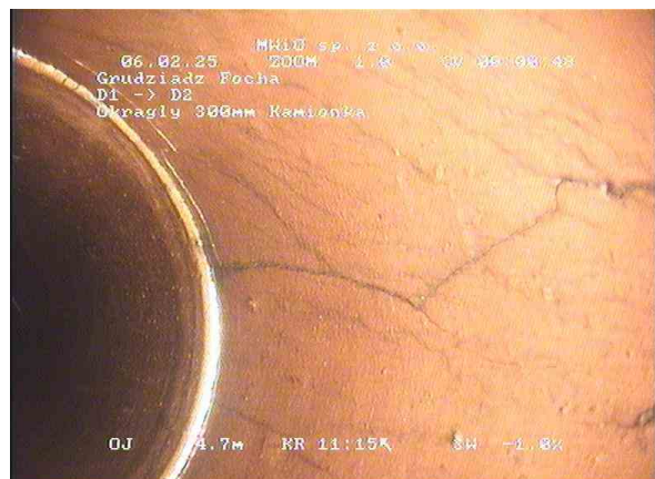
21e69528-a546-4879-9ab8-9a04c9a7de76_20250206_123645_302.jpg, 00:00:36, 5.21 Szczelina, pęknięcie wzdłużne, 1mm szeroki przy 12 godz.
