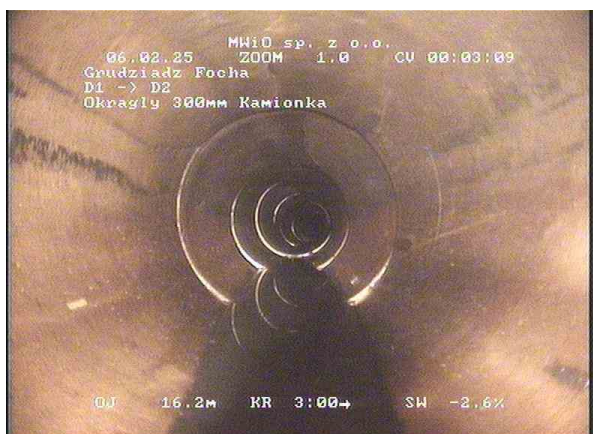
ac1f6b70-620f-4ac8-89f0-68ea16b85097_20250206_123956_662.jpg, 00:02:59, 16.28 Szczelina, pęknięcie wzdłużne, 1mm szeroki przy 12 godz.
