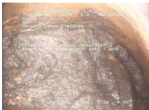
e88bf9d4-57f2-48ac-9041-73ce91dac207_20250206_123841_132.jpg, 00:02:12, 15.80 Połączenie, łącznik, przyłącze zamknięte, 150mm wysoki przy
