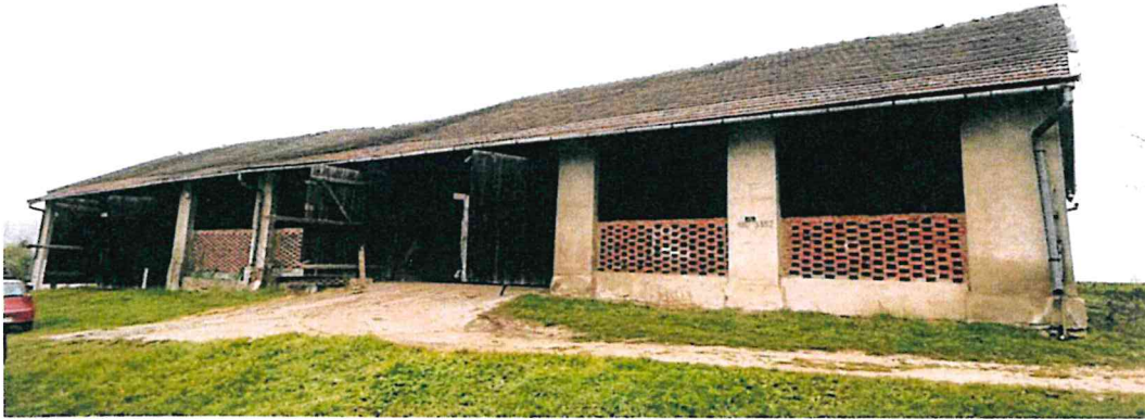
Fot. 1 Elewacja południowa budynku od strony wschodniej
