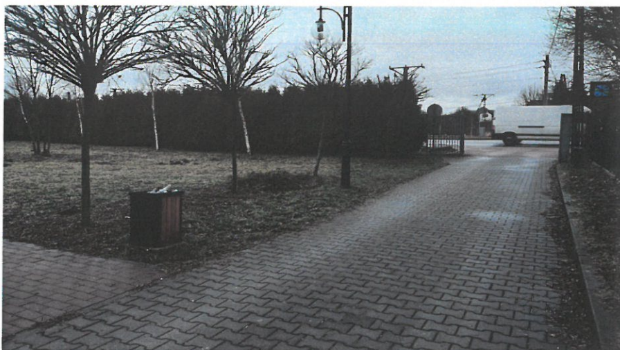
Fot. 7 – widok na drogę wewnętrzną w stronę ulicy Gliwickiej
