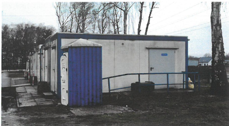
Fot. 4 – widok zaplecza kontenerowego
