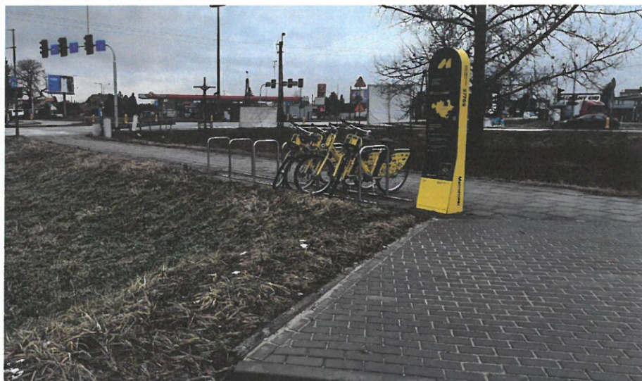
Fot.11 – widok na chodnik i fragment peronu autobusowego, gdzie planuje się montaż stacji napraw rowerów
