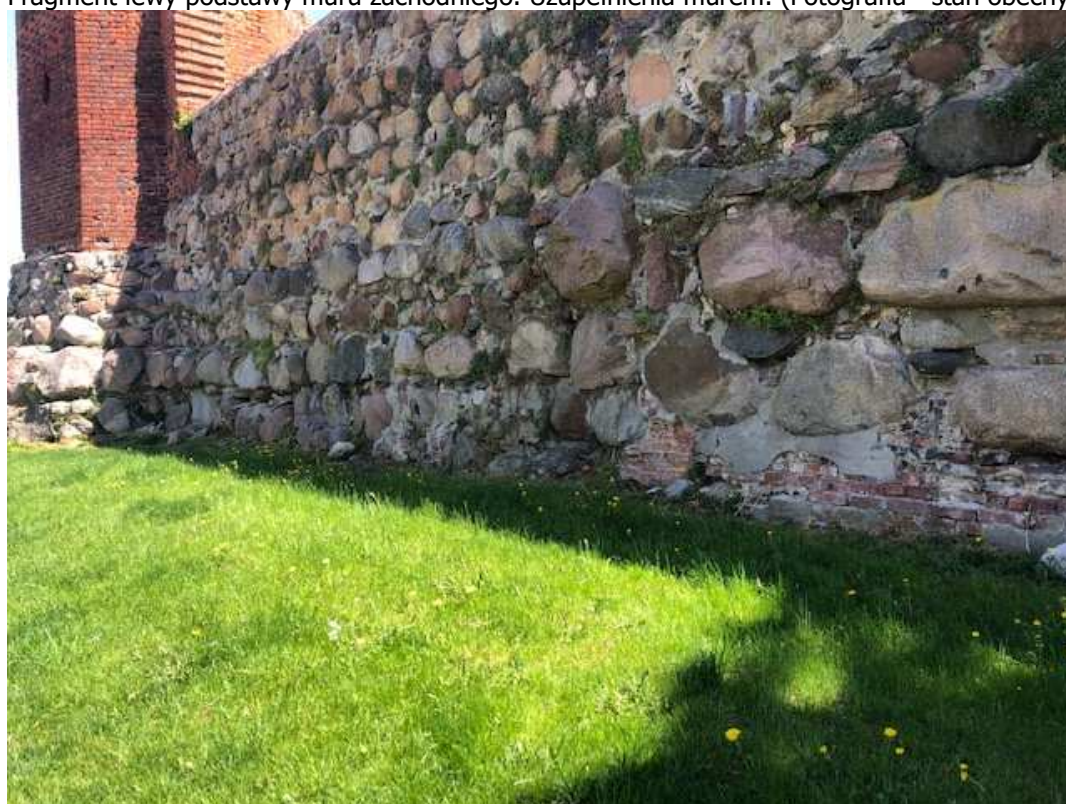
Fragment lewy podstawy muru zachodniego. Uzupełnienia murem. (Fotografia - stan obecny)
