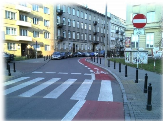
Foto nr 10. Kontrapas dla rowerów, barwa czerwona z oznakowaniem pionowym i poziomym na ulicy jednokierunkowej.
