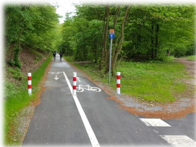
Foto nr 2. Wydzielona dwukierunkowa droga dla rowerów w terenie niezabudowanym (szerokość 2,5 m, nawierzchnia asfaltowa, oznakowanie pionowe + szlakowe, oznakowanie poziome).
