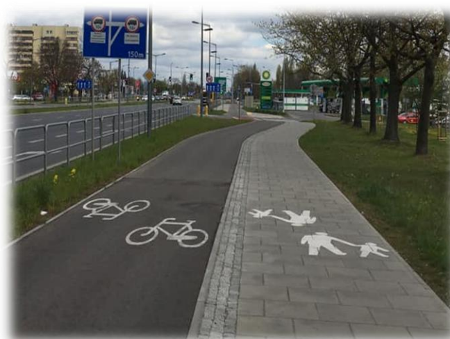
Foto nr 4. Droga dla pieszych i droga dla rowerów (separacja kostką granitową łupaną z różnicą wysokości pomiędzy drogą dla rowerów a drogą dla pieszych).
