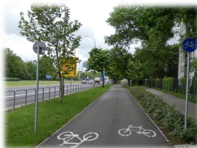
Foto nr 3. Wydzielona dwukierunkowa droga dla rowerów z separacją zieleniec od chodnika (szerokość 2,5 m, nawierzchnia asfaltowa, oznakowanie poziome).
