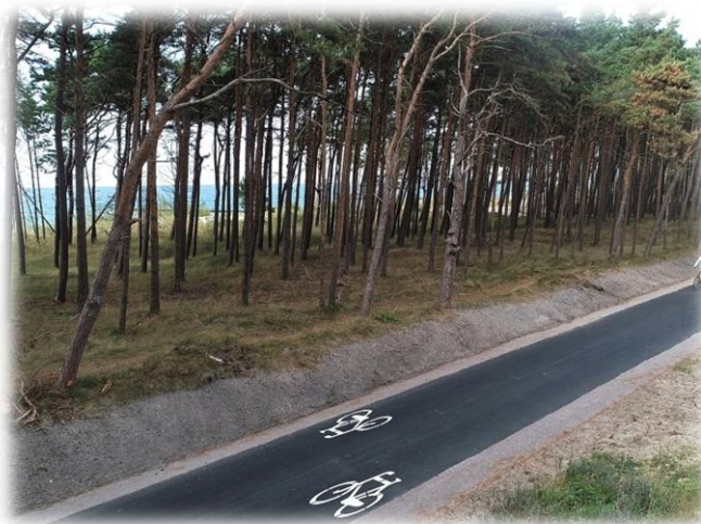
Foto. nr 21. Trasa dla rowerów - rekreacyjno-turystyczna (dwukierunkowa droga dla rowerów, nawierzchnia asfaltowa) biegnąca wzdłuż wybrzeża morza Bałtyckiego łącząca dwie miejscowości.
