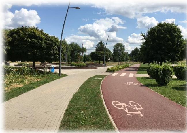
Foto nr 1. Wydzielona dwukierunkowa droga dla rowerów separacja zielenicem od chodnika w terenie zabudowanym (szerokość 2,5 m, nawierzchnia asfaltowa w barwie czerwonej, oznakowanie poziome, przejście dla pieszych).
