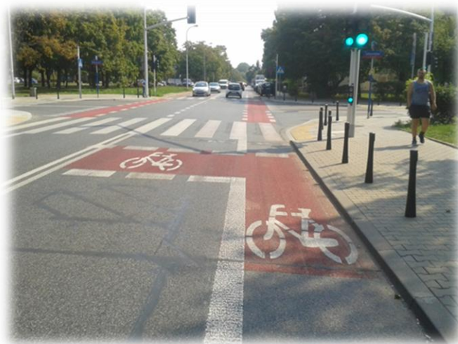
Foto. nr 13. Śluza dla rowerów na jednopasowym wlocie na skrzyżowanie z sygnalizacją świetlną.
