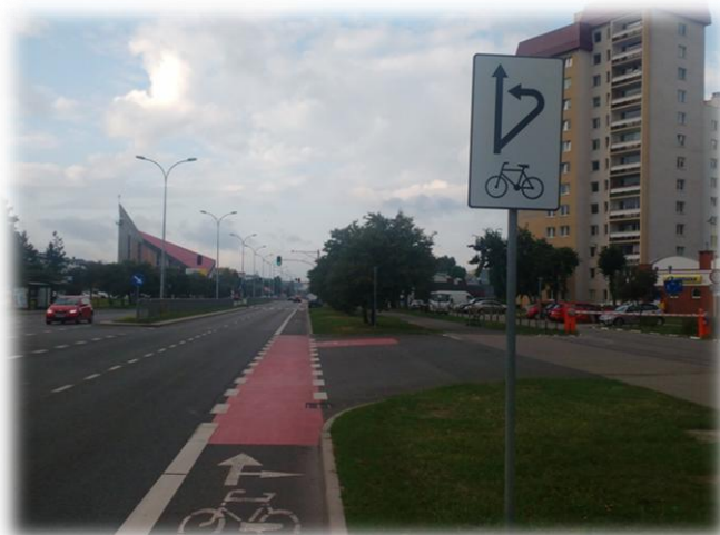
Foto. nr 14. Wlot na skrzyżowanie bez sygnalizacji świetlnej z informacją dla kierującego rowerem, który ma zamiar skręcić w lewo, że jest wyznaczona śluza oczekiwania po prawej stronie. Manewr skrętu w lewo jest realizowany w dwóch etapach: skręt w prawo w kierunku śluzy, a następnie jazda ze śluzy na wprost.
