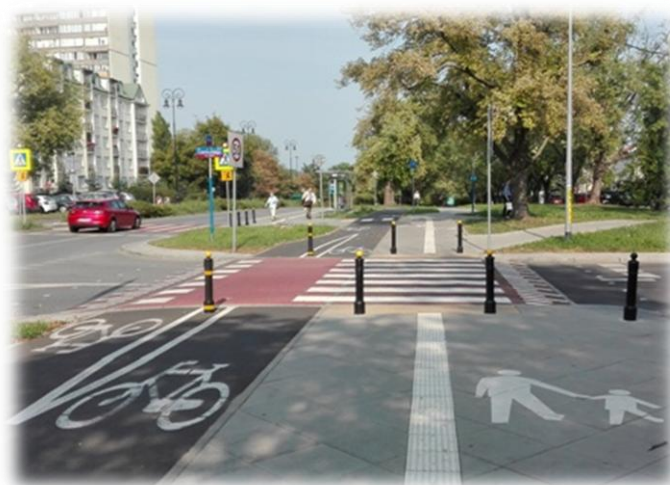
Foto. nr 12. Przejazd dla rowerzystów i przejście dla pieszych w obszarze zabudowanym na skrzyżowaniu z wyniesioną powierzchnią.
