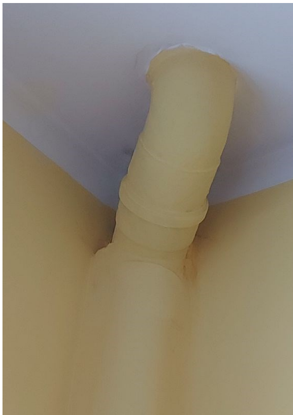
Fot. nr 17. Pion kanalizacji sanitarnej
