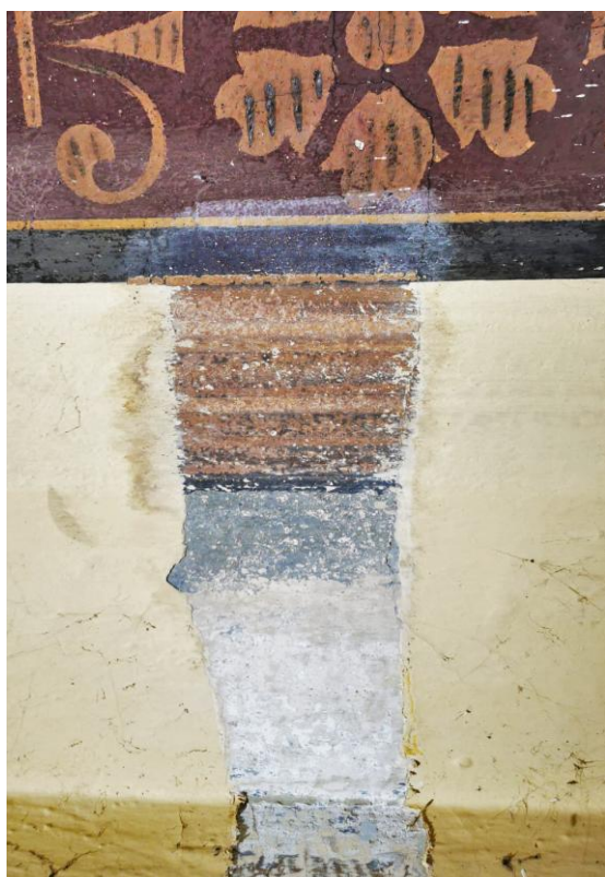
19. Odkrywka sondażowa na obramieniu malowidła,
