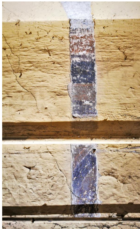
23. Odkrywka sondażowa na fasecie w górnej partii ściany zachodniej.
