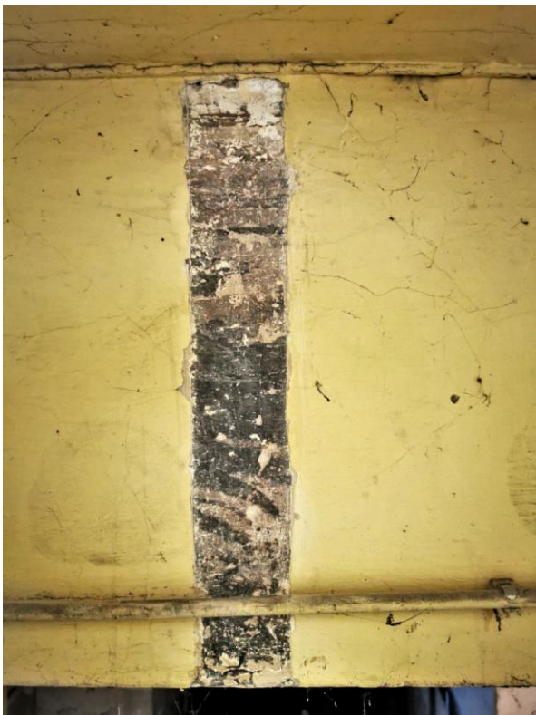
27. Odkrywka sondażowa na ścianie południowej powyżej przejścia do klatki schodowej.
