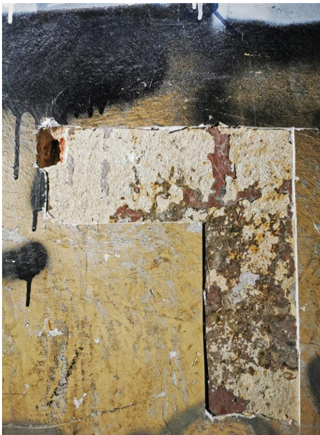
30. Odkrywka sondażowa w dolnej partii ściany zachodniej.
