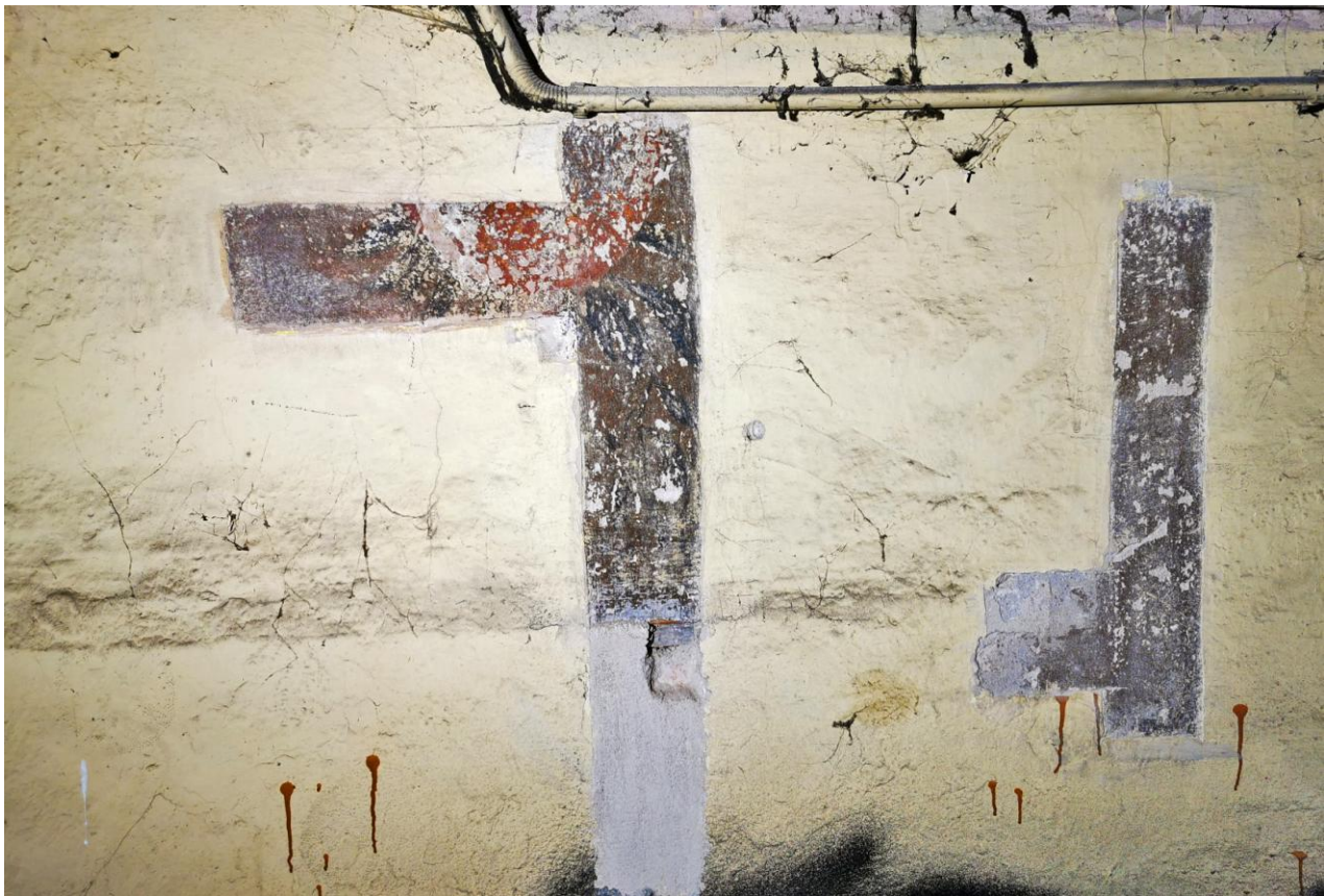
29. Odkrywki sondażowe w centralnej części ściany zachodniej
