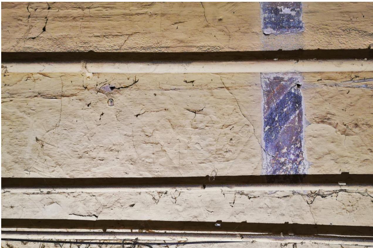
26. Fragment odkrywki sondażowej w górnej partii śiany zachodniej z widocznym śladem polichromii na nawarstwieniach.
