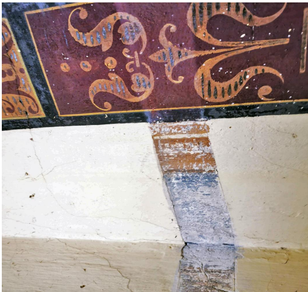
18. Odkrywka sondażowa na obramieniu malowidła i fascie
