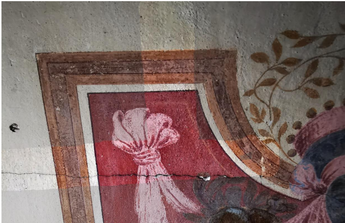
21. Odkrywka sondażowa na polichromii sufitu wykazująca stopień zabrudzenia.
