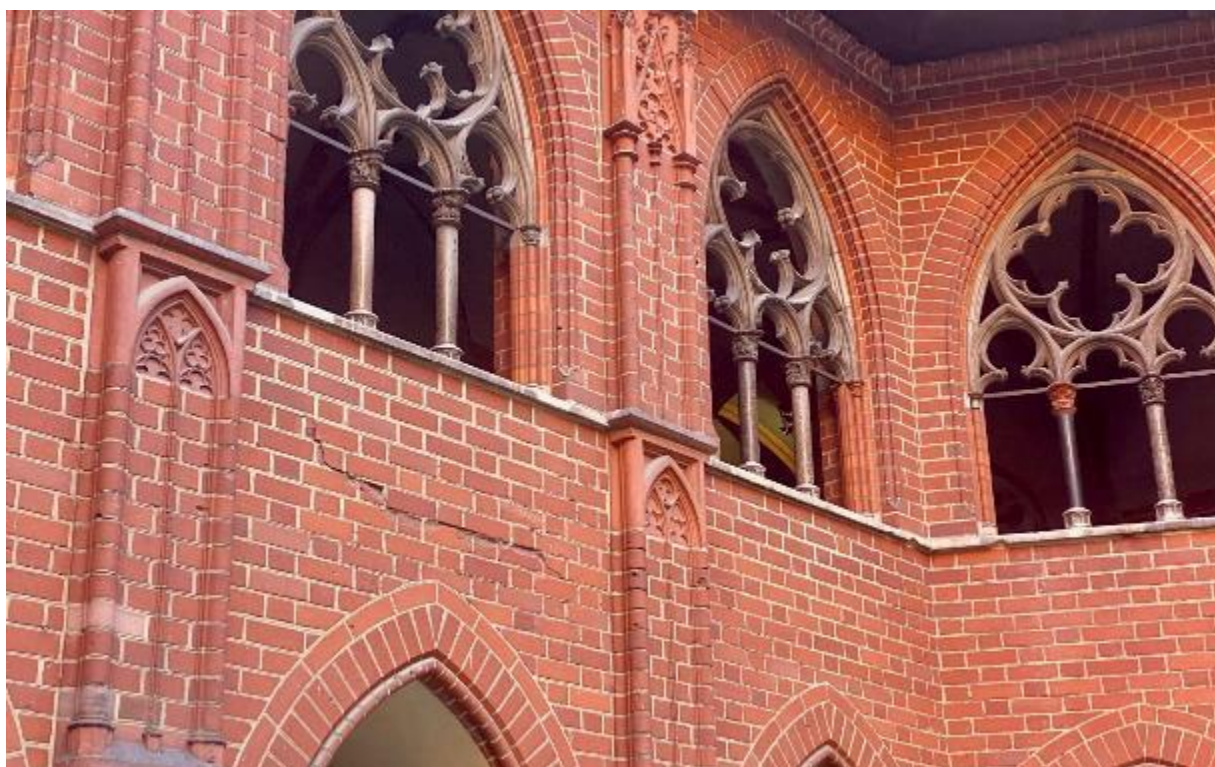
Ilustracja 40 Spękania spoin oraz materiału ceramicznego.
