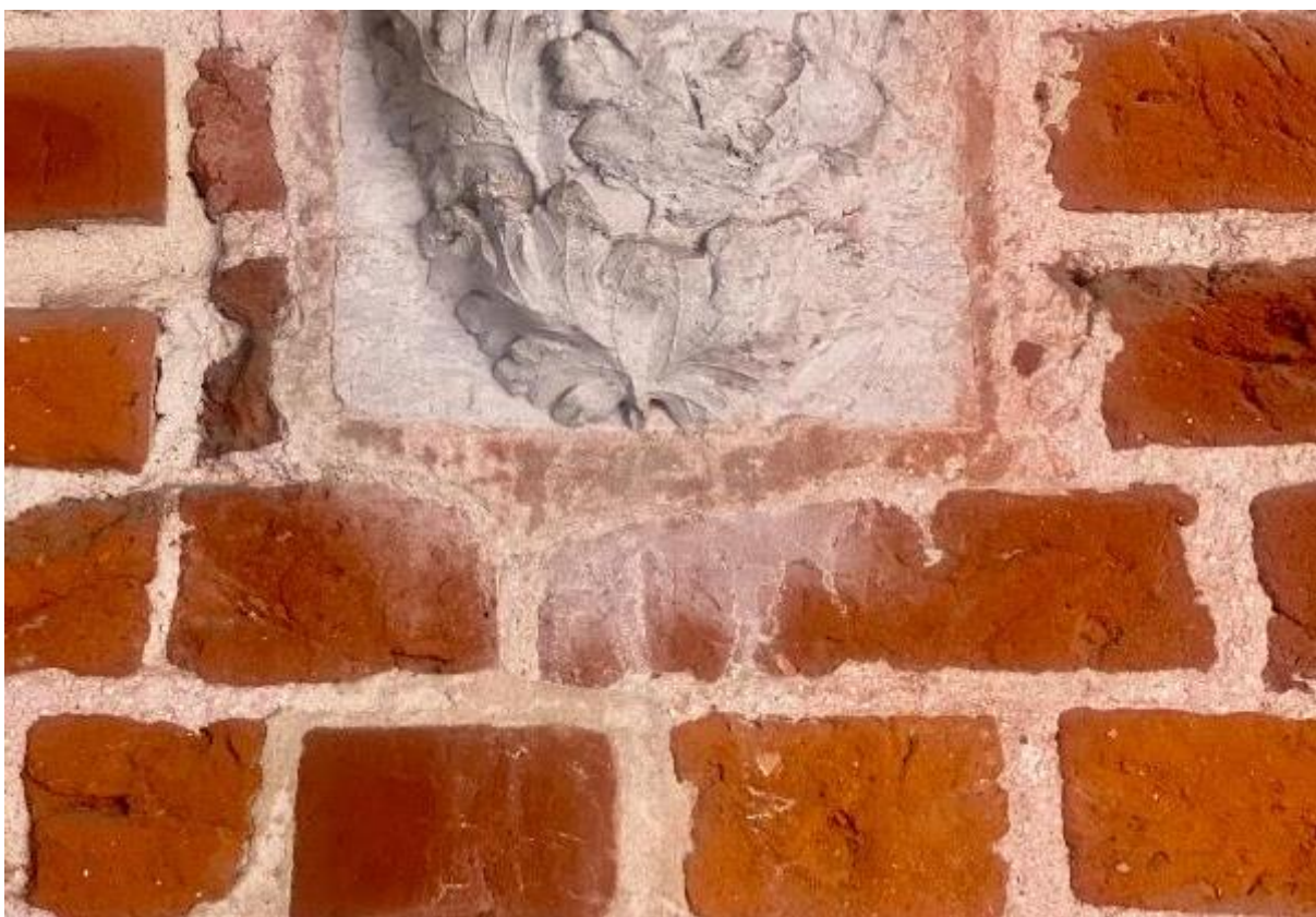
Ilustracja 26 Zabielenia węglanowe widoczne poniżej kamiennej konsoli.
