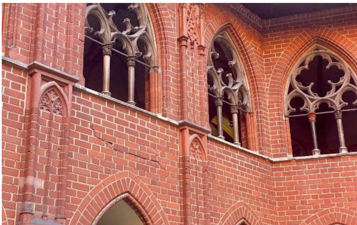
Ilustracja 40 Spękania spoin oraz materiału ceramicznego.
