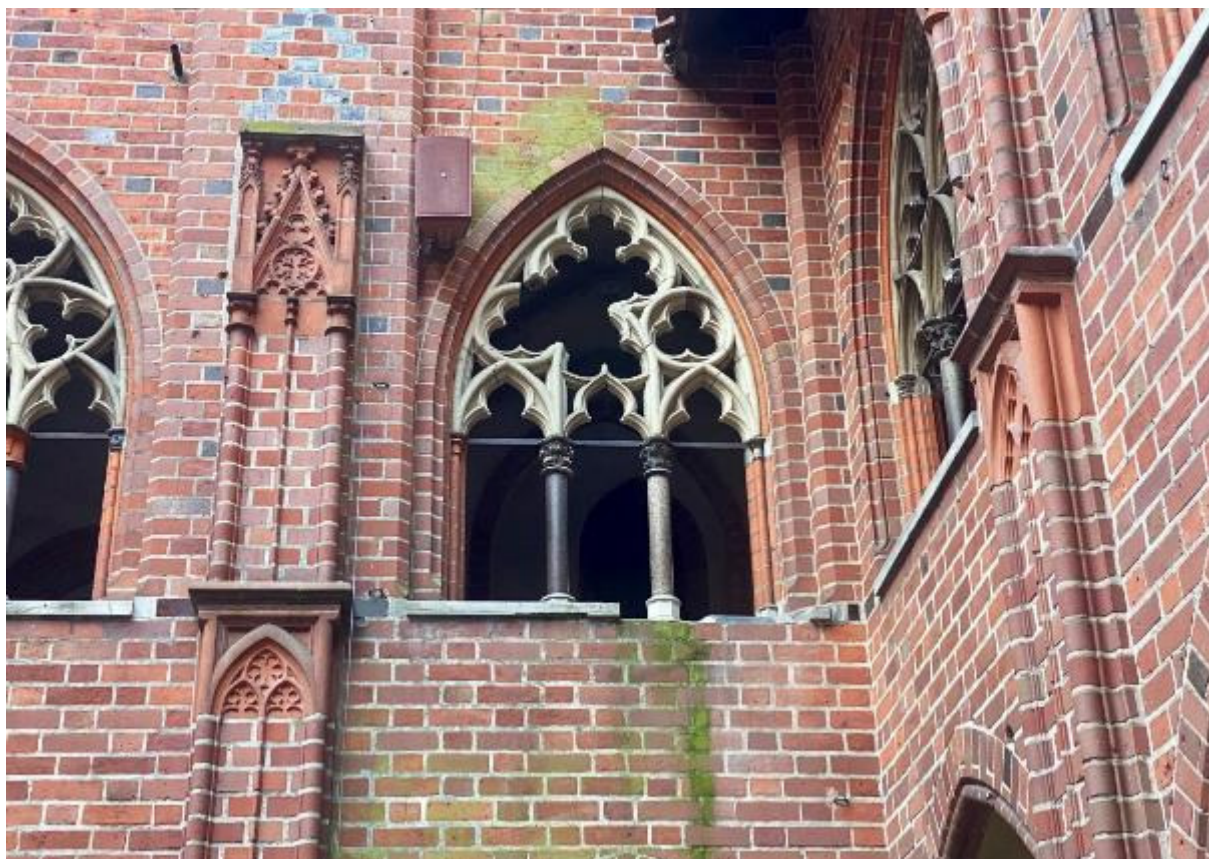
Ilustracja 39 Uszkodzenia maswerku, zniszczenia spowodowane działaniem wody.
