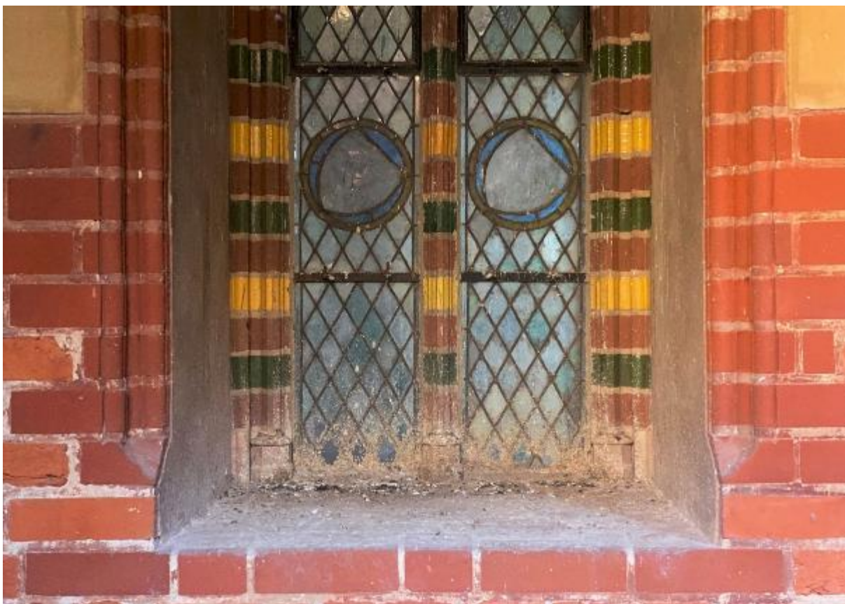
Ilustracja 35 Zniszczenia spowodowane przez obecność ptactwa.
