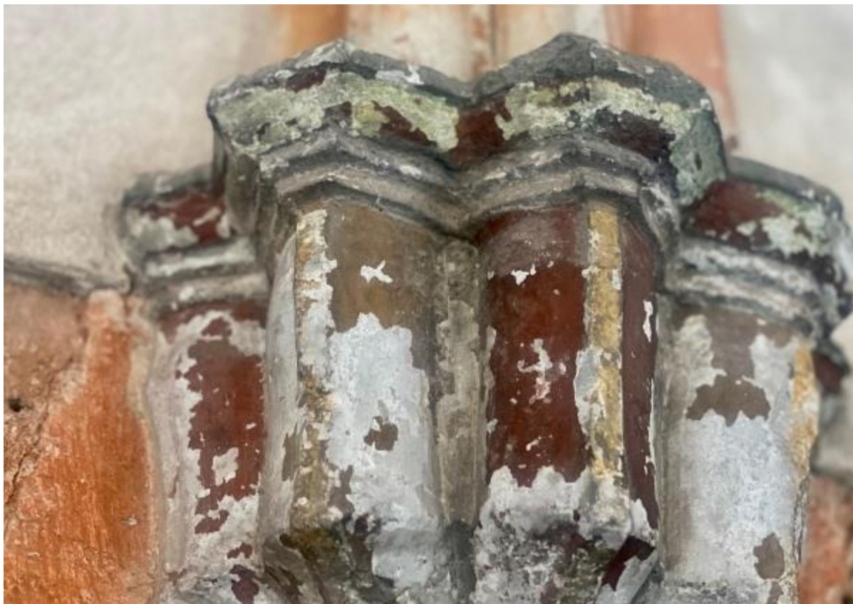
Ilustracja 27 Ubytki warstw malarskich występujące na detalu architektonicznym.
