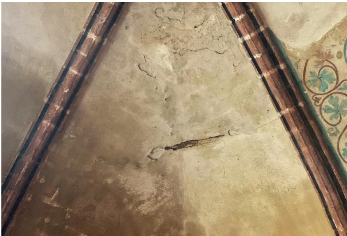
Ilustracja 22 Zniszczenia w obrębie sklepień.
