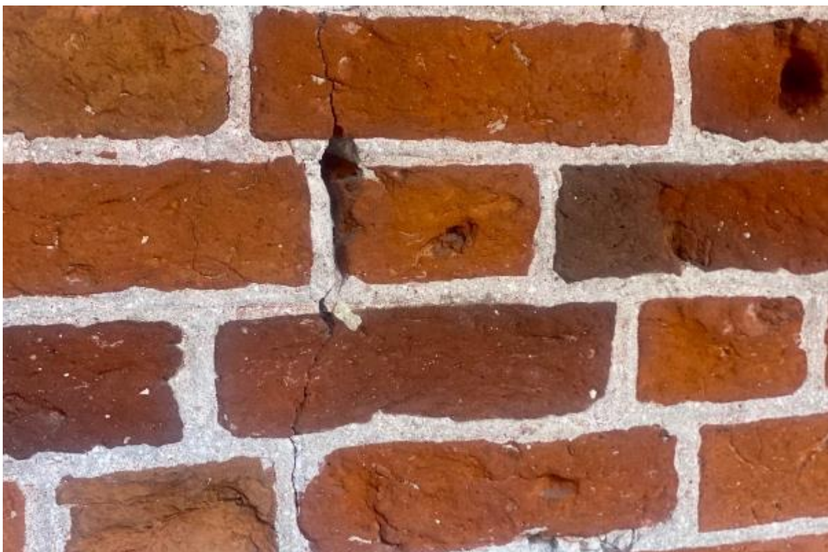
Ilustracja 31 Spękania w części muru oporowego.
