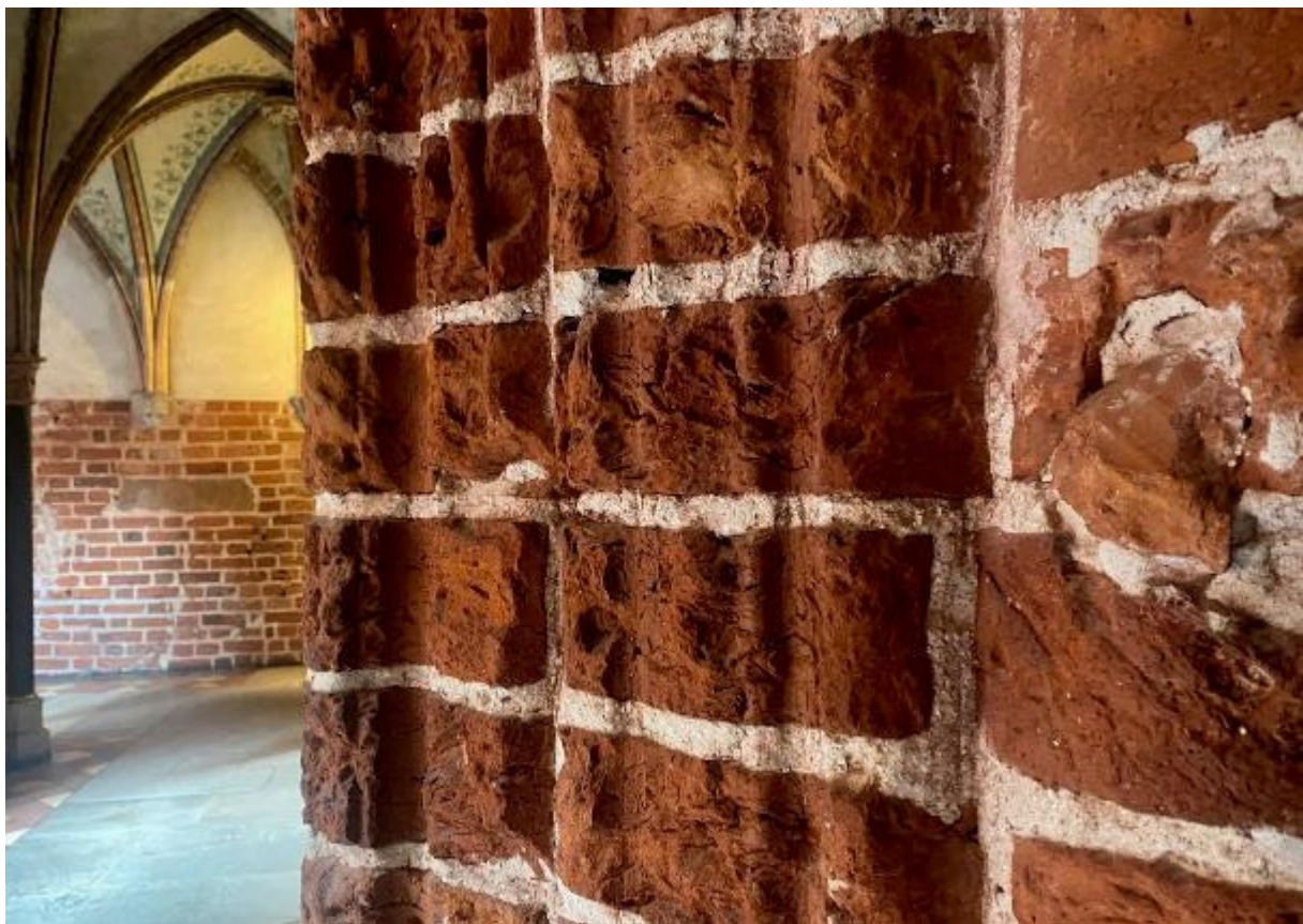
Ilustracja 34 Erozja materiału ceramicznego, materiał wymaga wzmocnienia strukturalnego.
