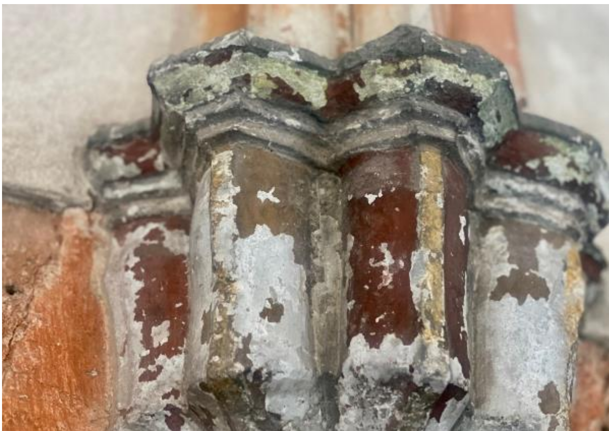
Ilustracja 27 Ubytki warstw malarskich występujące na detalu architektonicznym.
