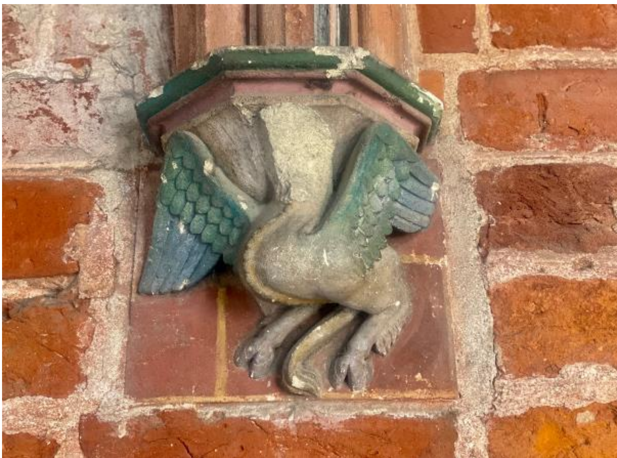
Ilustracja 25 Uszkodzenia kamiennej konsoli.
