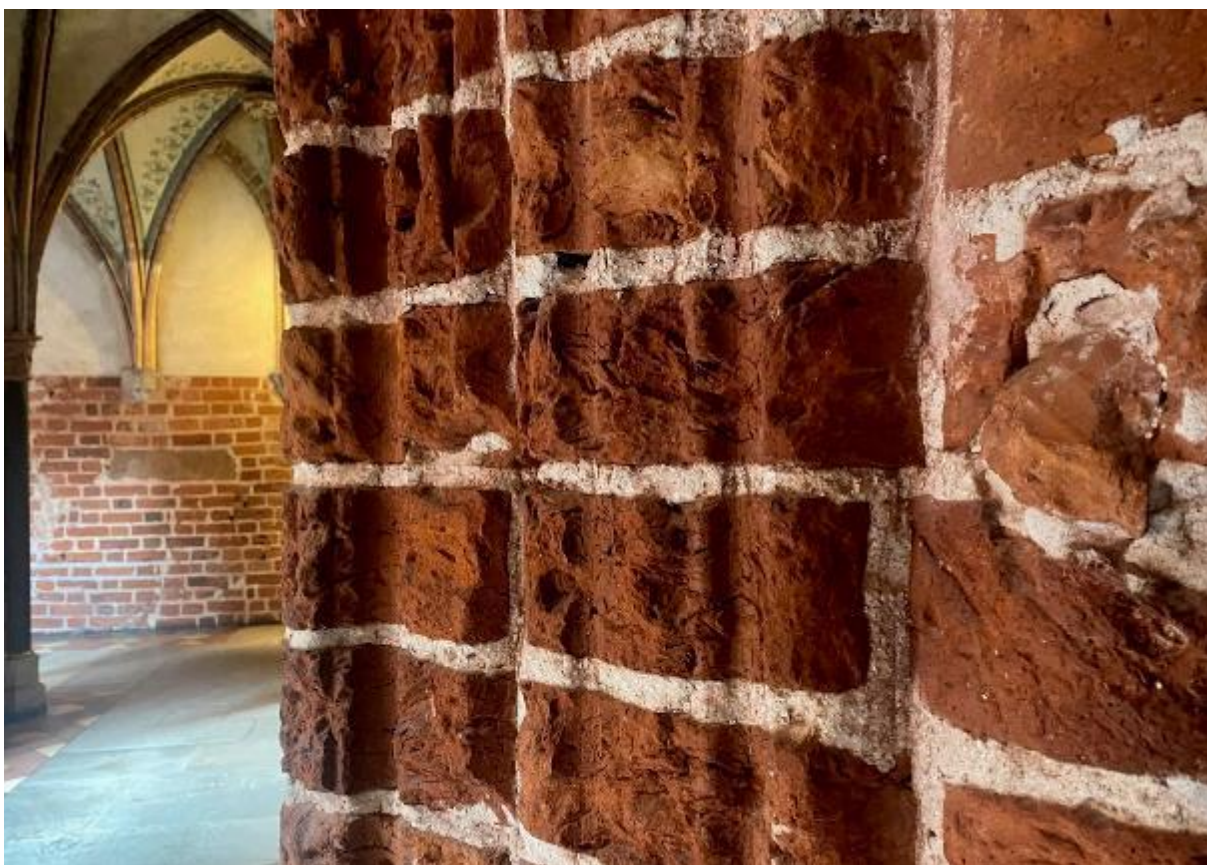
Ilustracja 34 Erozja materiału ceramicznego, materiał wymaga wzmocnienia strukturalnego.
