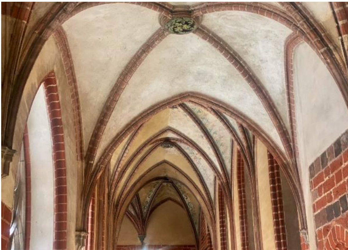
Ilustracja 20 Sklepienia częściowo pokryte zaprawą cementowo-wapienną.
