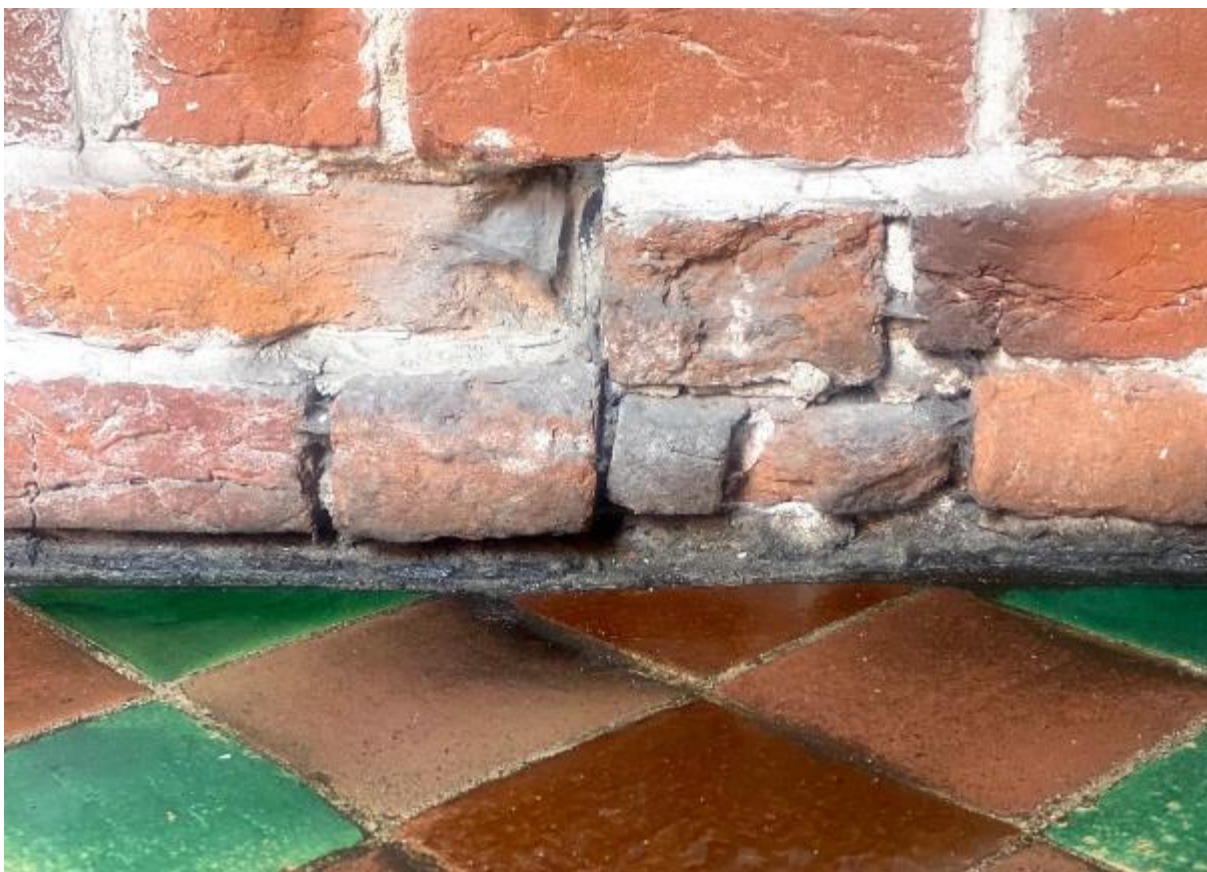
Ilustracja 33 W miejscu ubytków zbierają się zabrudzenia. Można również zaobserwować osypywanie się spoiny.
