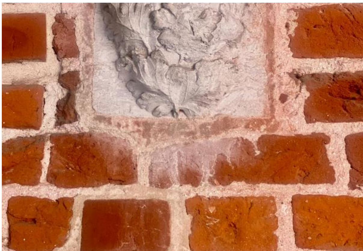
Ilustracja 26 Zabielenia węglanowe widoczne poniżej kamiennej konsoli.
