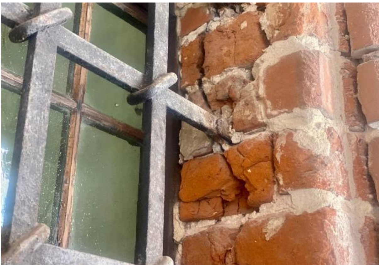
Ilustracja 29 Destrakcja cegieł w miejscu połączenia z metalową kratą.
