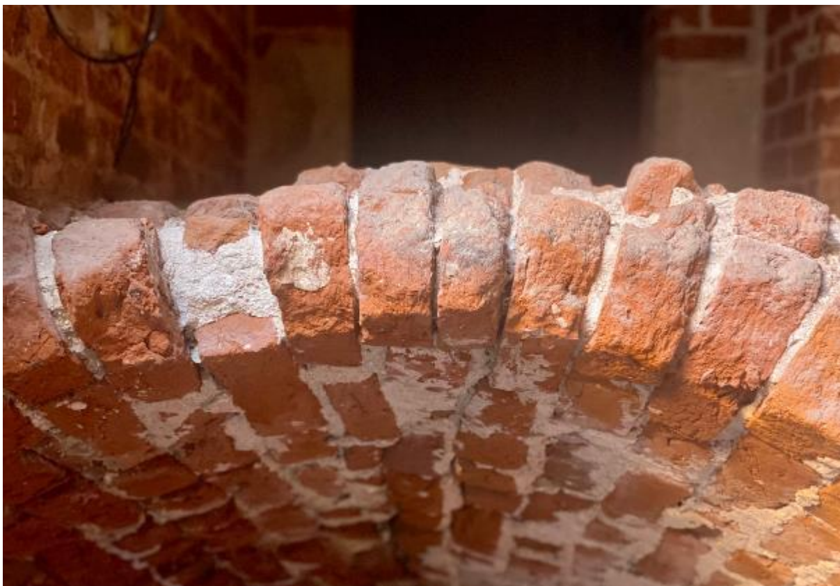
Ilustracja 44 Uszkodzenia cegieł przy wejściu do piwnic.
