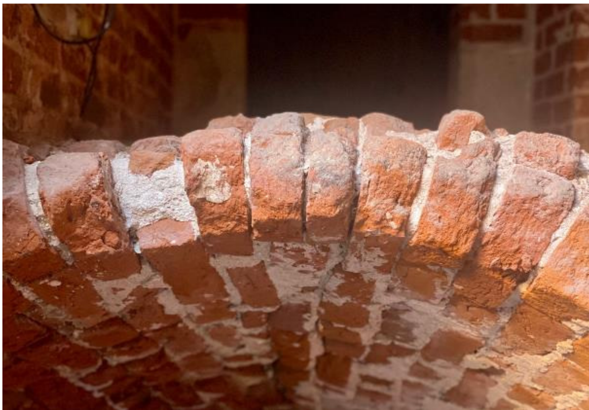
Ilustracja 44 Uszkodzenia cegieł przy wejściu do piwnic.
