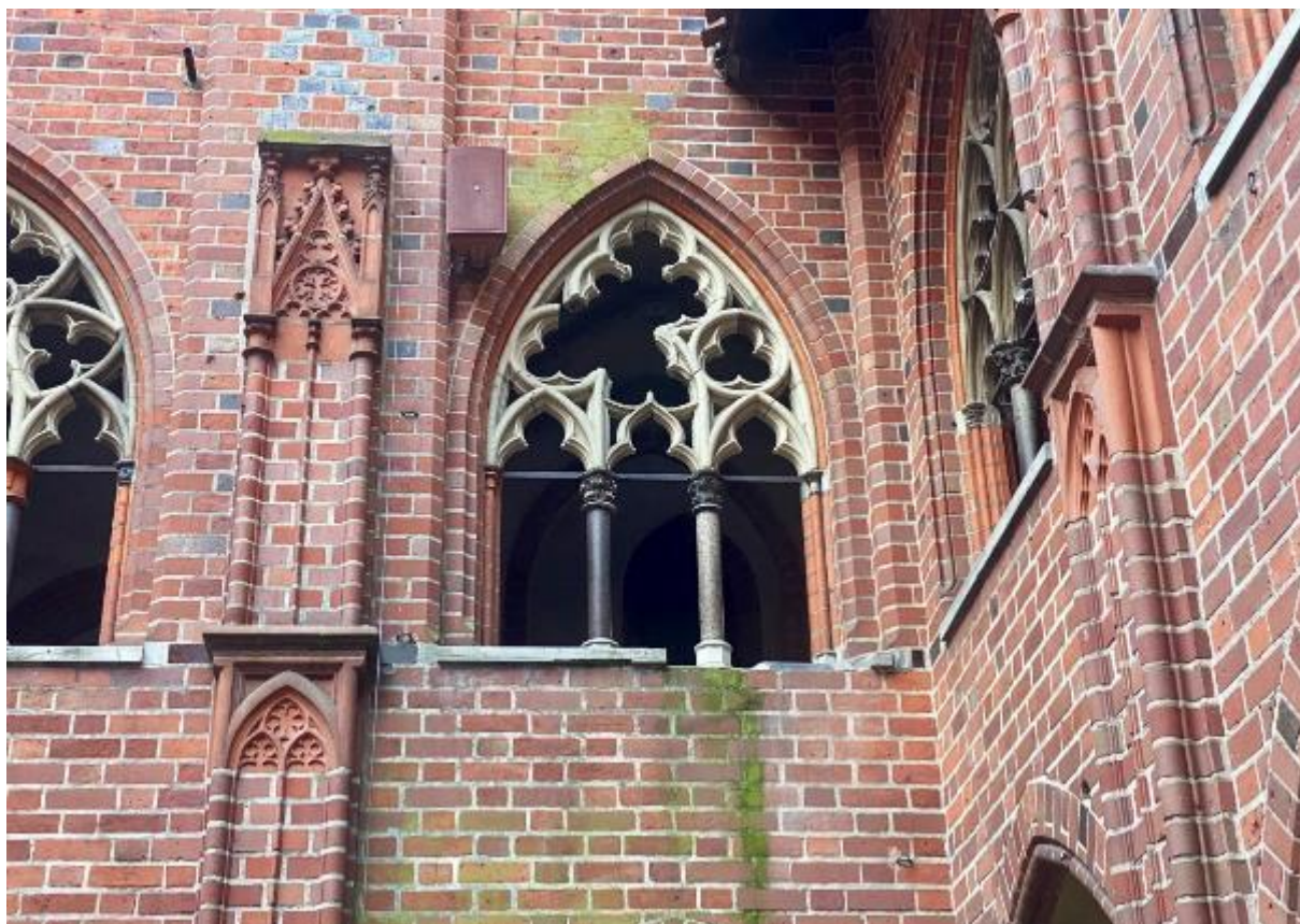
Ilustracja 39 Uszkodzenia maswerku, zniszczenia spowodowane działaniem wody.
