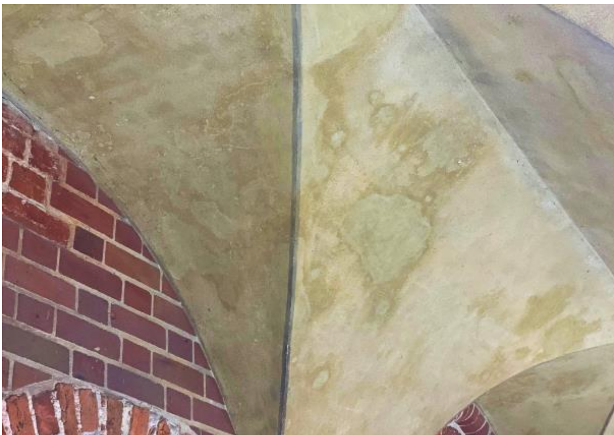
Ilustracja 45 Część tynków wymaga scalenia kolorystycznego.
