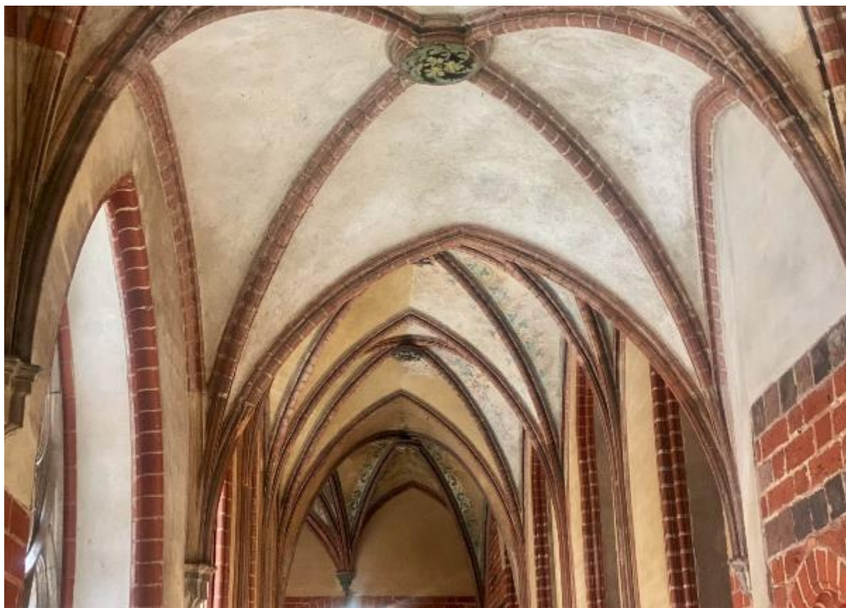
Ilustracja 20 Sklepienia częściowo pokryte zaprawą cementowo-wapienną.
