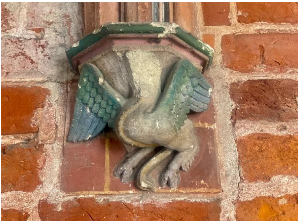
Ilustracja 25 Uszkodzenia kamiennej konsoli.
