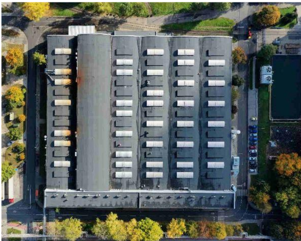
Zdj. 3. Widok hali D2. Północna krawędź hali po lewej stronie. Obecnie na nawach od II (podwyższona) do VI przy krótszych krawędziach świetlików są panele fotowoltaiczne
