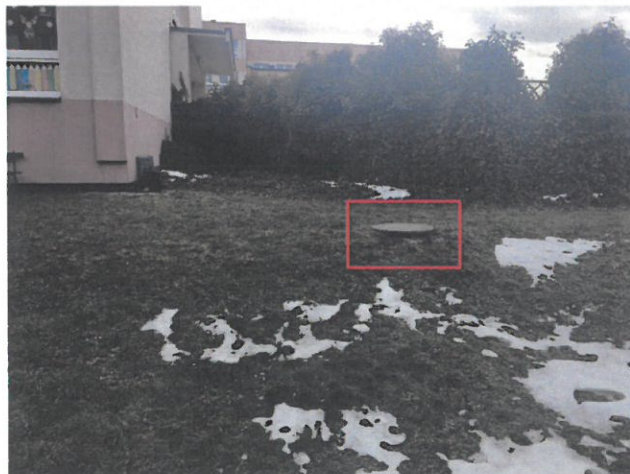
Rys. 9 Widok istniejącego trawiastego placu zabaw A1 z zaznaczeniem studzienki do zabezpieczenia wokół.
