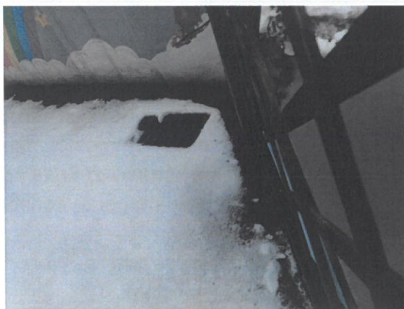
Rys. 11 Widok istniejącego wpustu kanalizacji deszczowej na terenie placu zabaw B.
