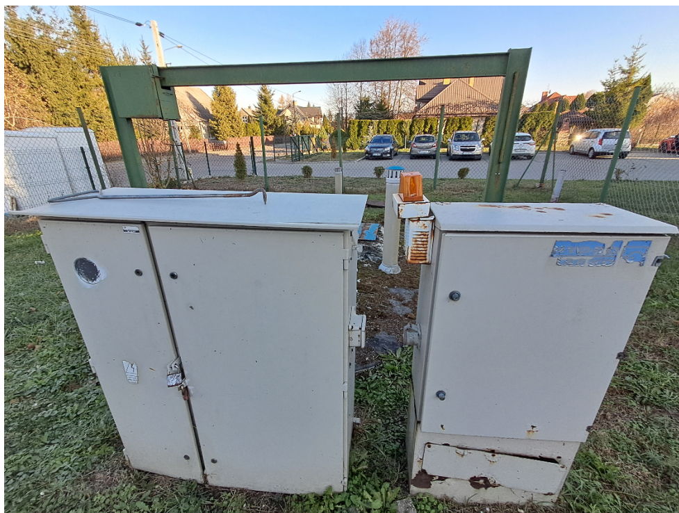
Rys. 1 – Szafa sterownicza (do demontażu) i zasilania(do –przeniesienia) przy obiekcie Fasty II
