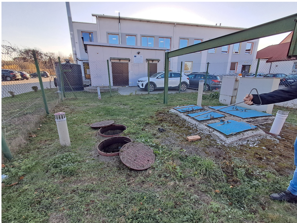
Rys. 3. Widok na pompownie Fasty II i komorę rozdzielczą (odsunięte dwa włazy)
