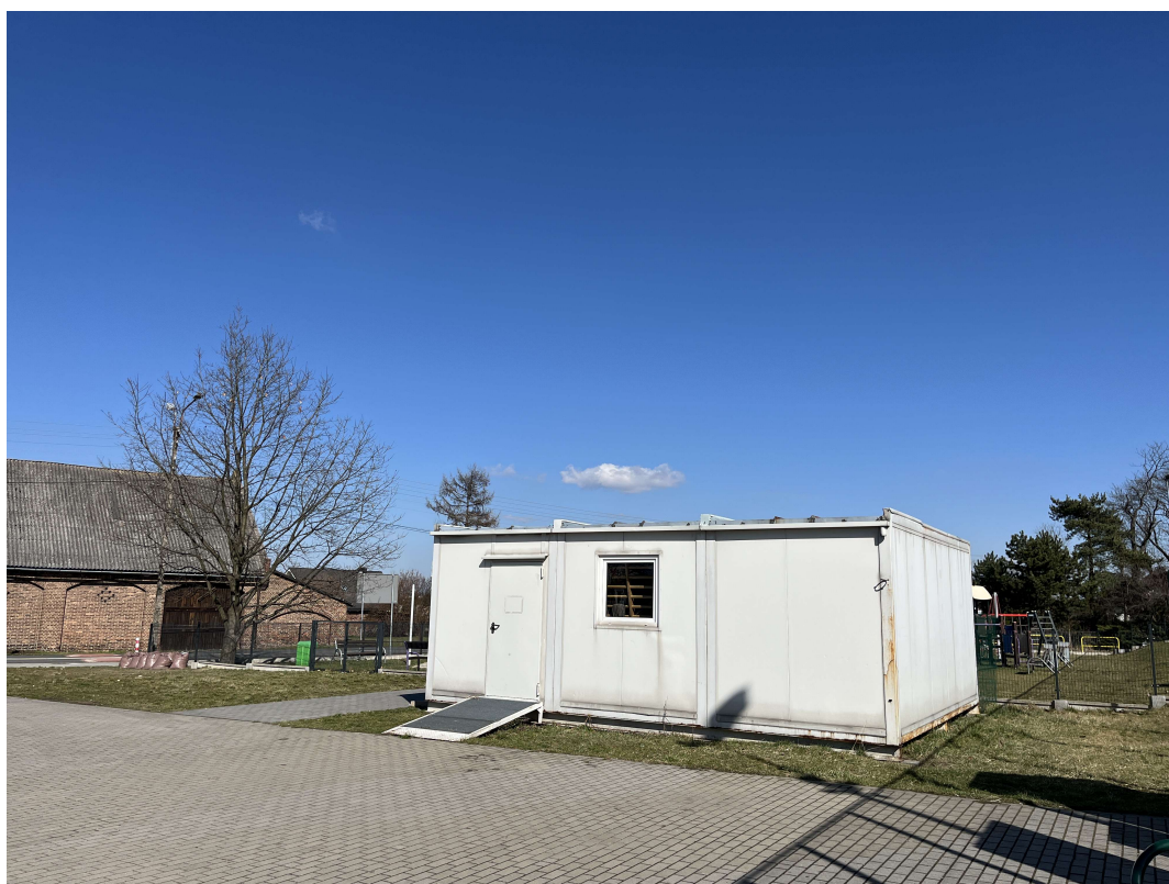
Fot. 4 Widok 2 kontenera od strony parkingu
