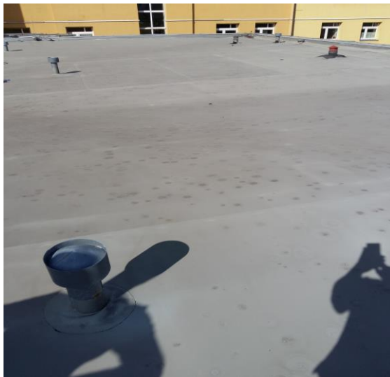
Fot. Widok nakryw murków, obróbek blacharskich, instalacji odgromowej, doszczelnień kominków wentylacyjnych.
