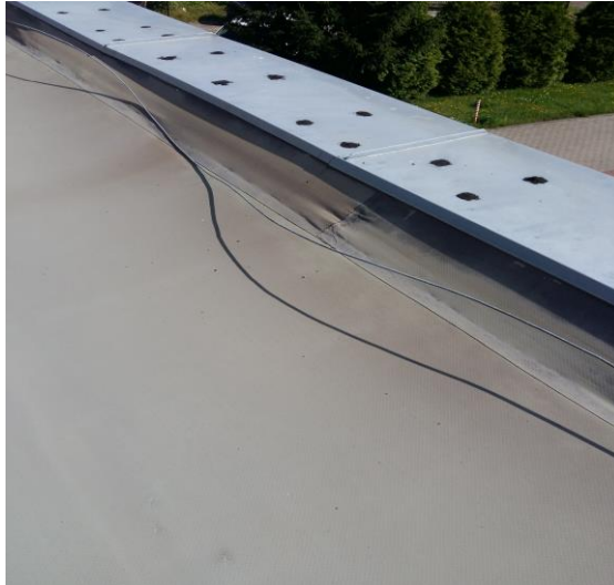
Fot. Widok uszkodzeń membrany dachowej
