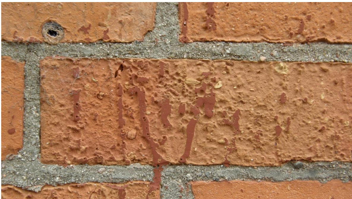
Il. 4. Lico cegły po chemicznym usunięciu wtórnej powłoki malarskiej. Fot. P. Owczarek
