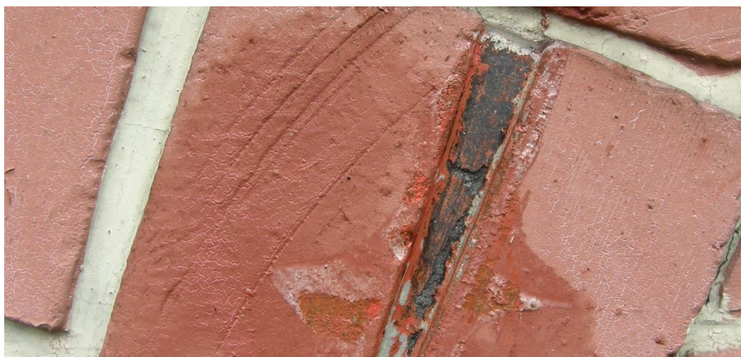
II. 2. Oryginalna, grafitowa zaprawa spoinowa z elewacji szpitala. Fot. P. Owczarek
