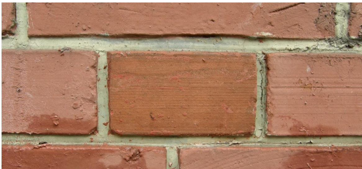
Il. 3. Lico cegły po chemicznym usunięciu wtórnej powłoki malarskiej. Fot. P. Owczarek
