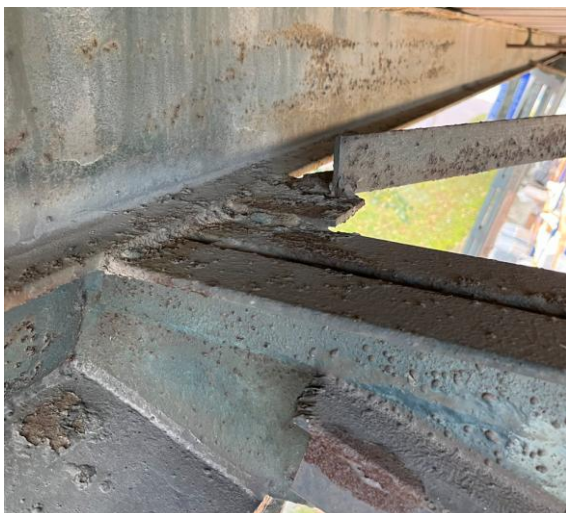
Rysunek 14. Widok na łączenie stężenia połaciowego z górnym pasem dźwigara kratowego
