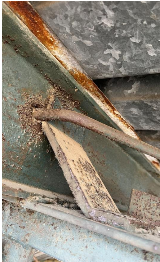
Rysunek 15. Płatwie – przekrój i oparcie na dźwigarze
