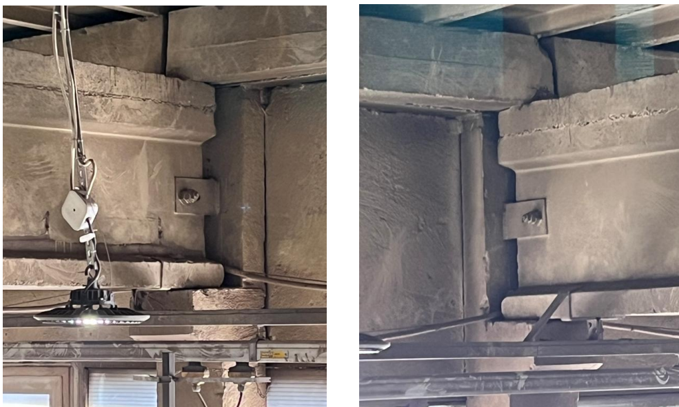
Rysunek 25. Podparcie widełkowe dźwiga – widełki poziome
