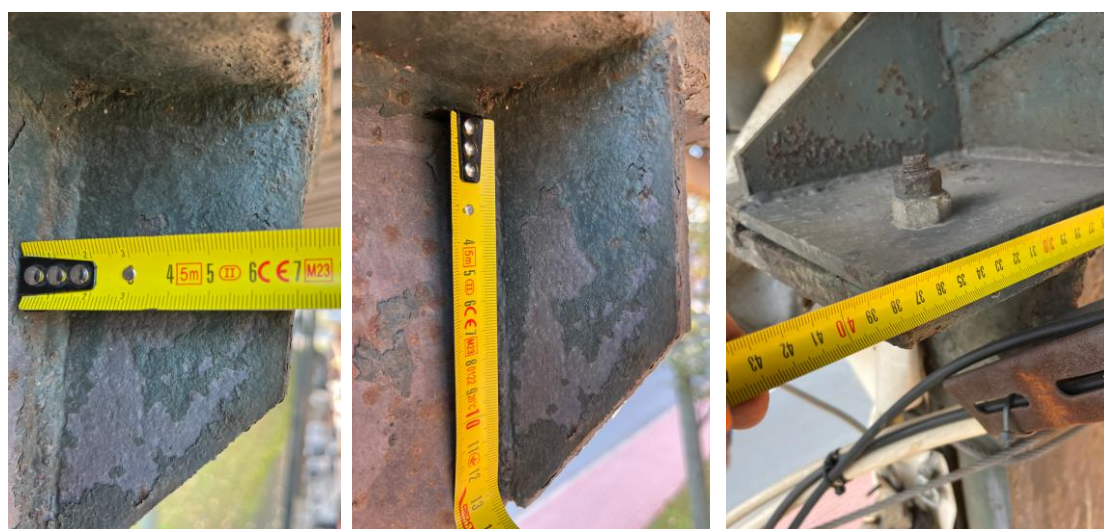
Rysunek 11. Blacha trapezowa i blacha pozioma – głowica słupa
