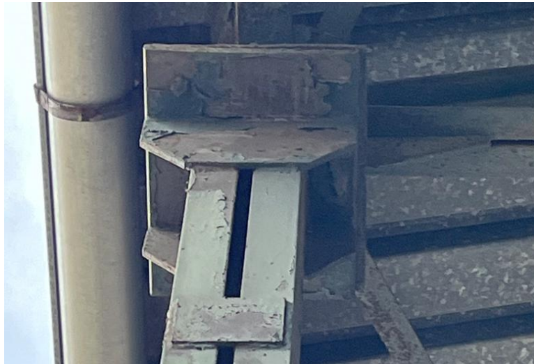
Rysunek 7. Oparcie przegubowe kratownicy na słupie oraz głowica słupa
