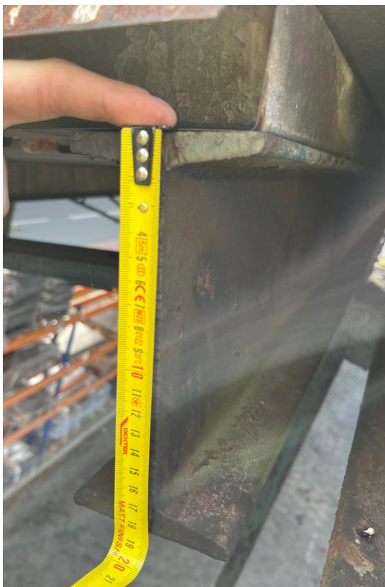
Rysunek 15. Płatwie – przekrój i oparcie na dźwigarze
