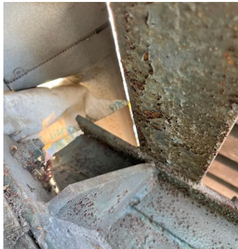
Rysunek 14. Widok na łączenie stężenia połaciowego z górnym pasem dźwigara kratowego
