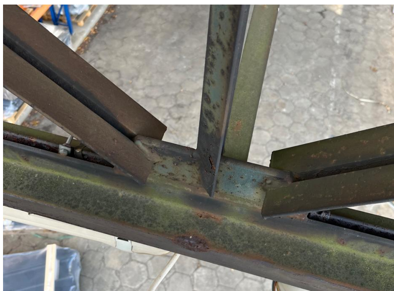
Rysunek 13. Pas dolny – węzeł z centralnym słupkiem pionowym
