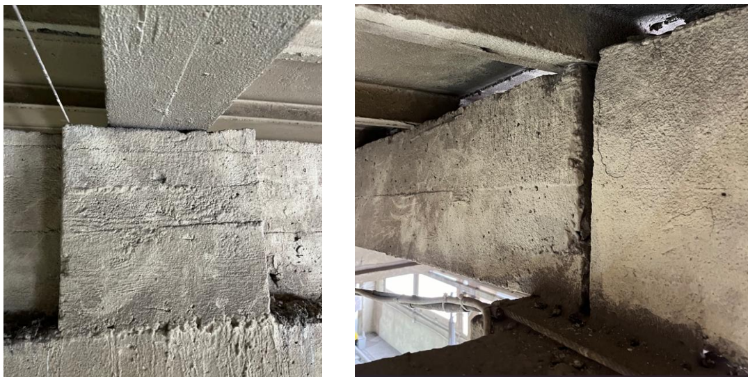
Rysunek 27. Cokół i oparcie żeber na dźwigarze
