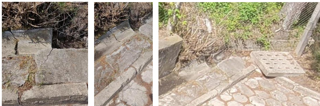
Zdjęcie nr 11-13. Uszkodzone koryto betonowe odprowadzające wody opadowe z dachu zbiornika i komory zasuw.
