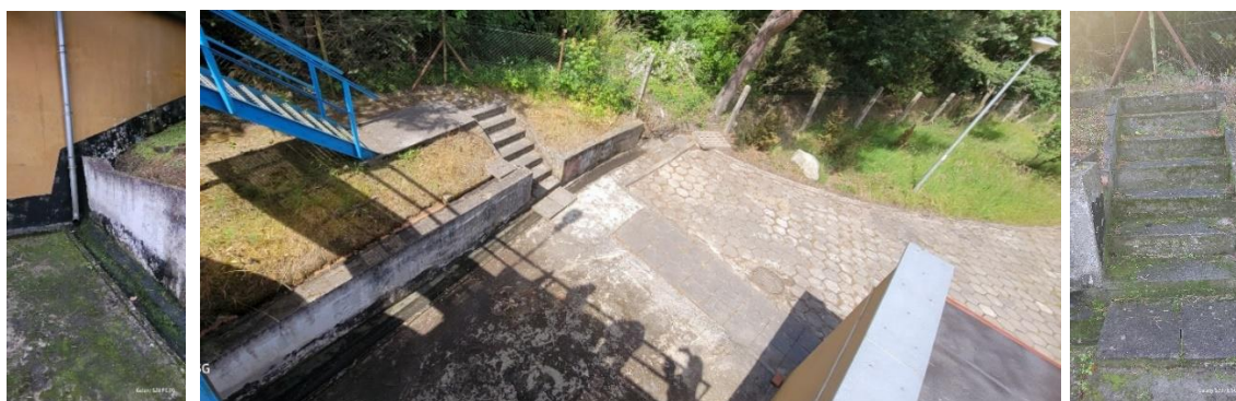
Zdjęcie nr 27-29. Umocnienie skarpy przy wejściu na pomost obsługowy zbiornika wody.
