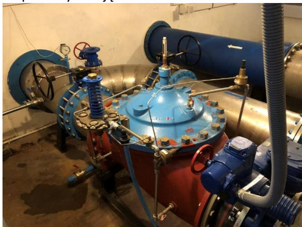
Zdjęcie nr 48. Zawór redukcyjny ciśnienia DN500 wraz z bypassem oraz przepustnicami na rurociągu napełniającym
