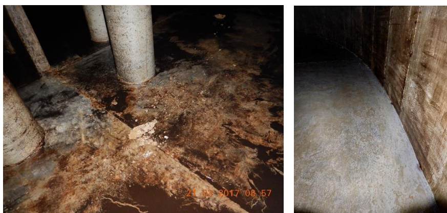
Zdjęcie nr 6-7. Płyta denna wraz ze słupami oraz miejsce łączenia płyty dennej ze ścianą zewnętrzną.
