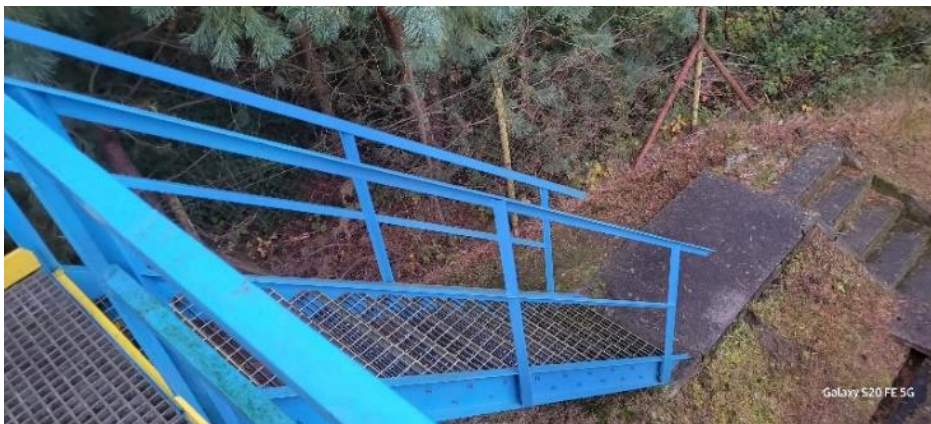
Zdjęcie nr 20-23. Konstrukcja stalowa pomostu i schodów.
