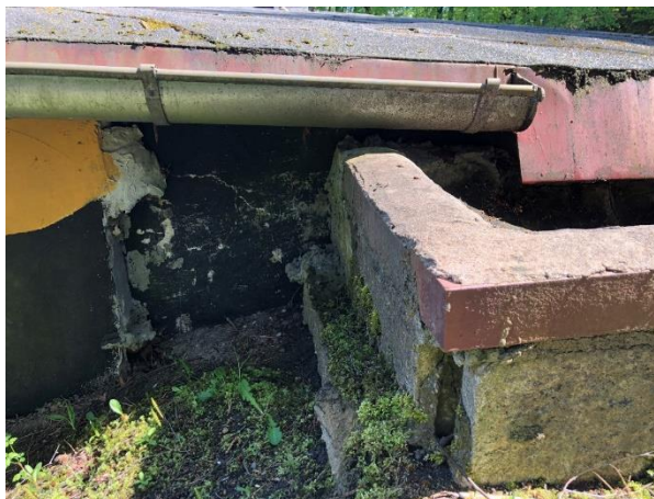
Zdjęcie nr 34. Stan elewacji zbiornika na granicy z izolacją ziemną.
