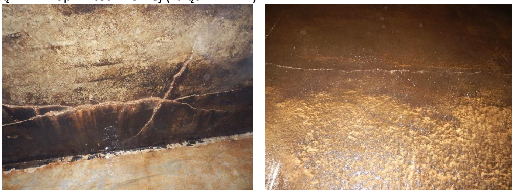
Zdjęcie nr 30-31. Wnętrze zbiornika wody (ściana zewnętrzna).
