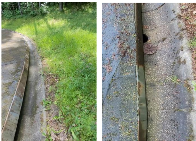
Zdjęcie nr 9-10. Odwodnienie (koryto betonowe) dachu na części obsypanej ziemią.
