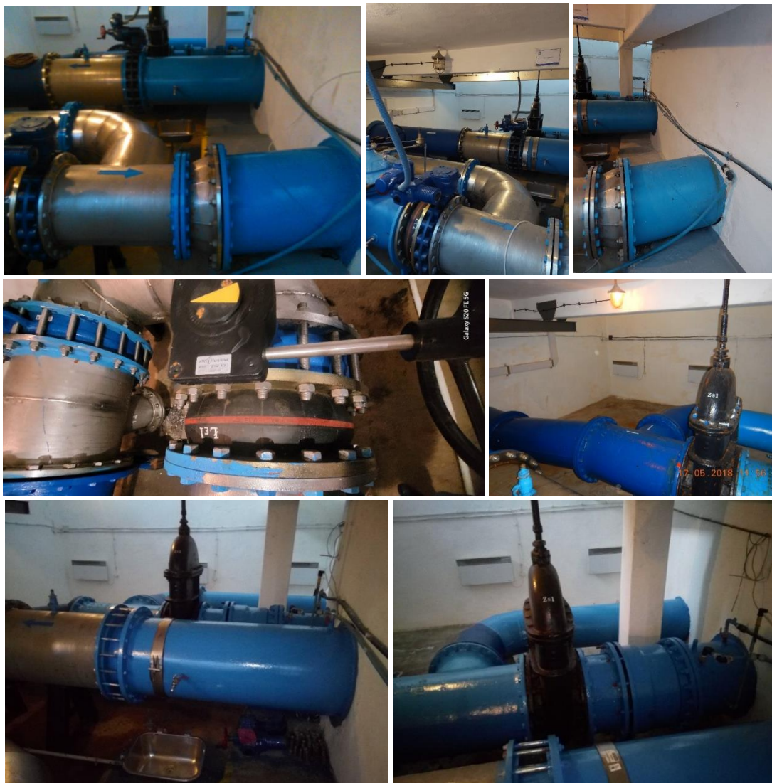
Zdjęcie nr 50-56. Rurociągi technologiczne wraz z armaturą w komorze zasuw – poziom „-1”.
