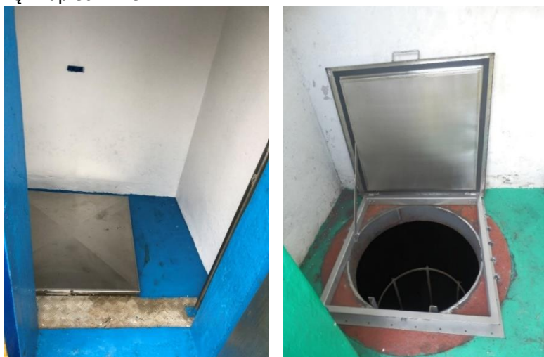
Zdjęcie nr 18-19. Wejście do zbiornika z nadbudówki wraz z widokiem drabiny.
