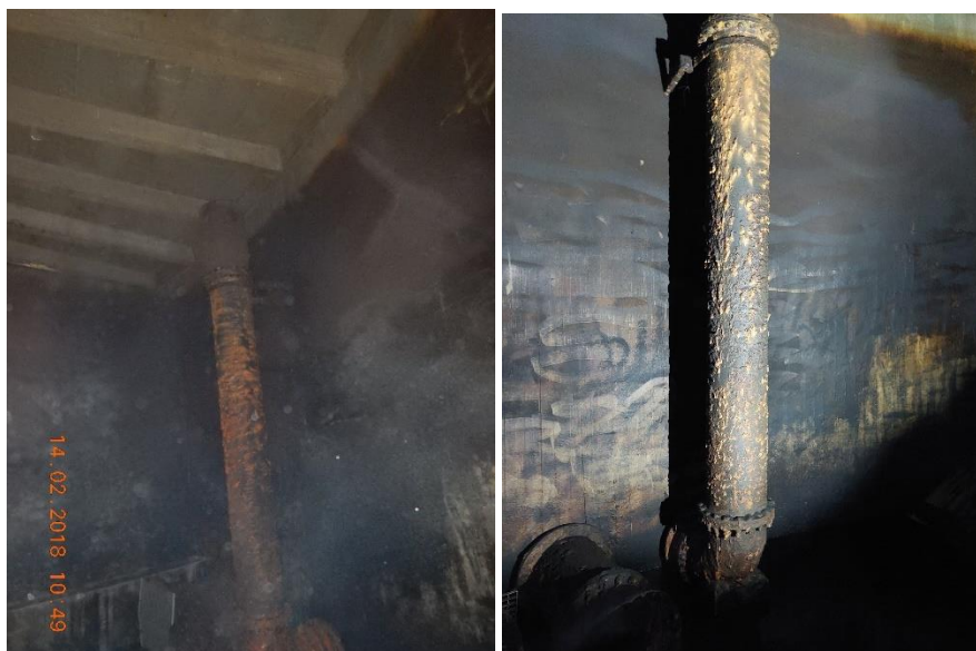
Zdjęcie nr 39-40. Rurociąg przelewowy.
