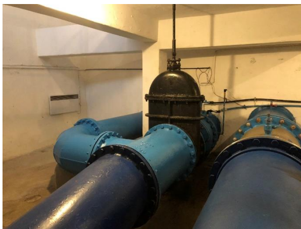
Zdjęcie nr 49. Zasuwa DN600 na rurociągu zrzutu oraz dwa rurociągi, przelewowy i poboru wody
