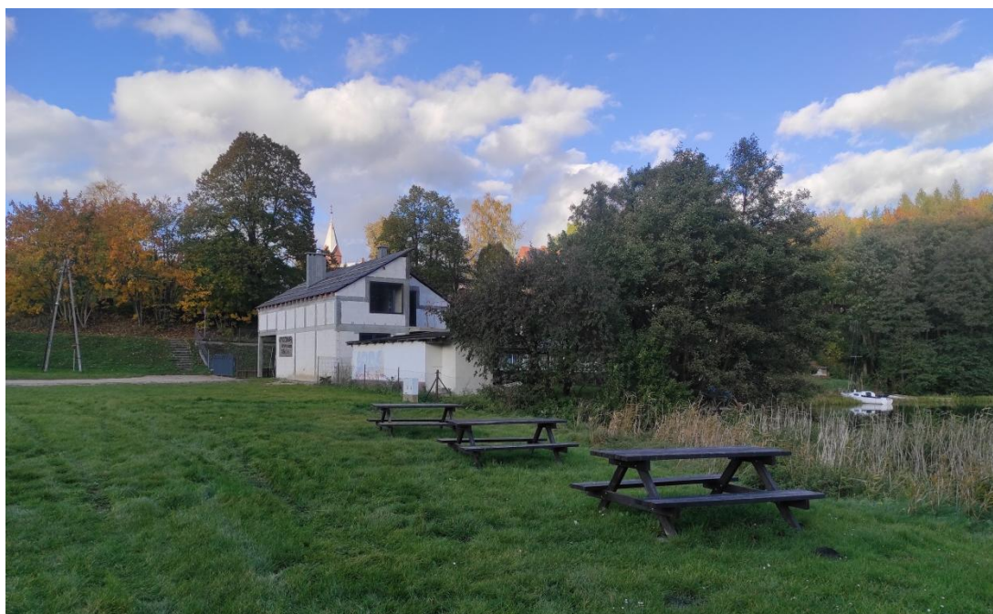
Zdj.3. Dz. 214/5 widok na istniejącą część rekreacyjną
