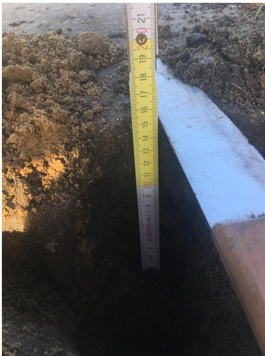
Zdj. 1. Przekrój konstrukcji drogi przy punkcie nr 2.
