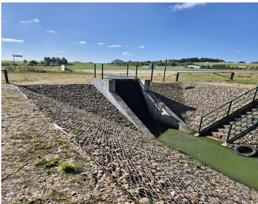
Fot 2. Do Władysławka- przepust DN 800
