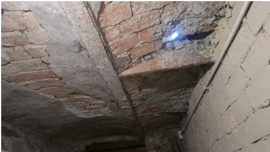
Fot. 4 Strop odcinkowy uszkodzony
