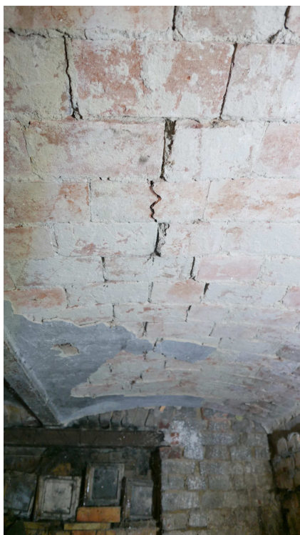
Fot. 6 Strop odcinkowy uszkodzony
