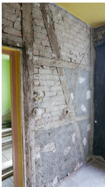
Fot. 11 Ściana ryglowa podłużna budynku
