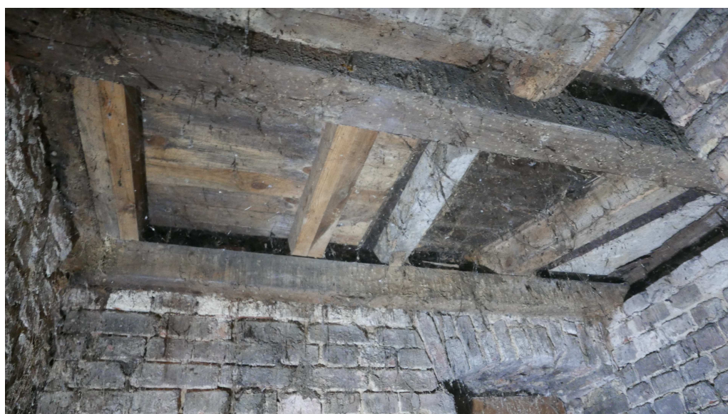
Fot. 9 Uszkodzony podest wejściowy klatki schodowej
