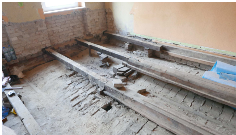
Fot. 14 Odkryty, uszkodzony strop odcinkowy w pom. nr 10 w lokalu nr 1
