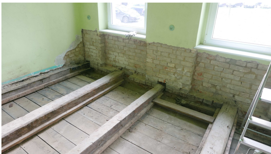
Fot. 13 Odkryty, uszkodzony strop w pom. nr 9 w lokalu nr 1
