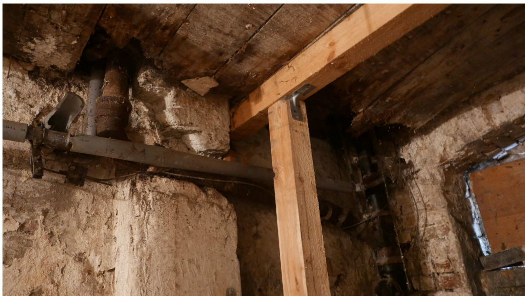
Fot. 8 Uszkodzony, podstemplowany strop pod kuchnią lokalu nr 2
