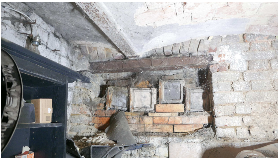
Fot. 5 Strop odcinkowy uszkodzony
