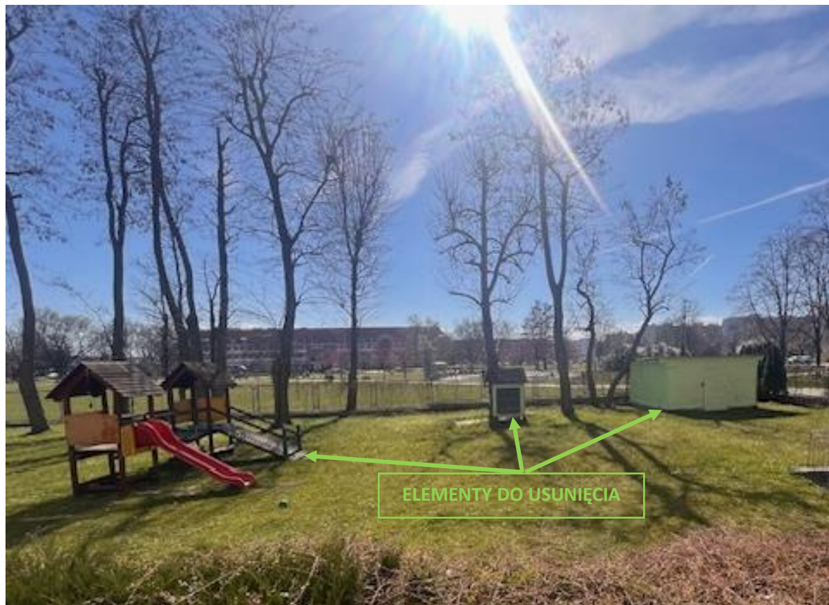
Fot. 8, 9 – Istniejące elementy placu zabaw przewidziane do rozbiórki i usunięcia
