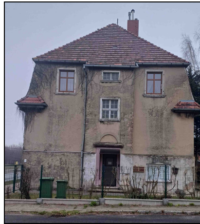
↑ Fot. 2. Elewacja boczna wejściowa od ul. Klonowej
