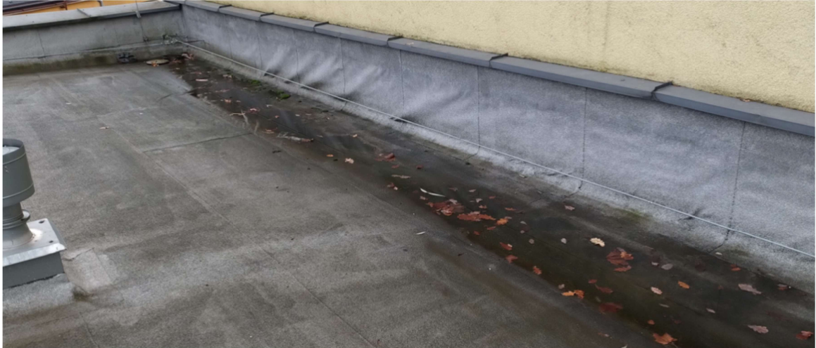
Dach niski – połać D2: ściana wzdłuż osi 2, pomiędzy osiami E i G
